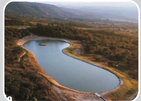
La Cosecha de Agua de Crucita Oriente, tiene un espejo de agua de 17,000 metros cúbicos del que dependen los 40 sistemas de riego por goteo de ultra baja presión.
