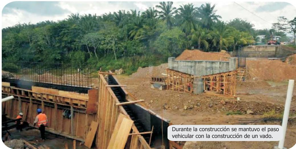
Durante la construcción se mantuvo el paso vehicular con la construcción de un vado.
