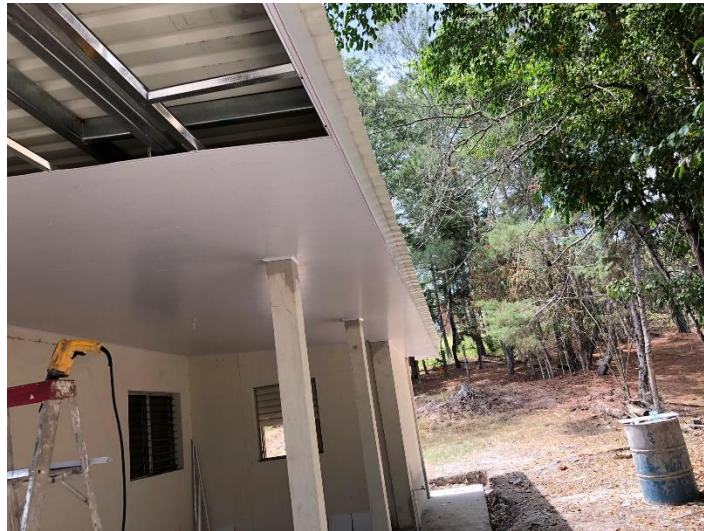
Imagen 1. Instalación de Cielo Falso y Fascia
