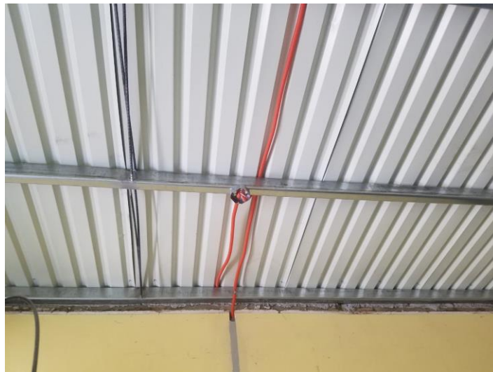
Imagen 6. Instalaciones de cableado para circuito de iluminación
