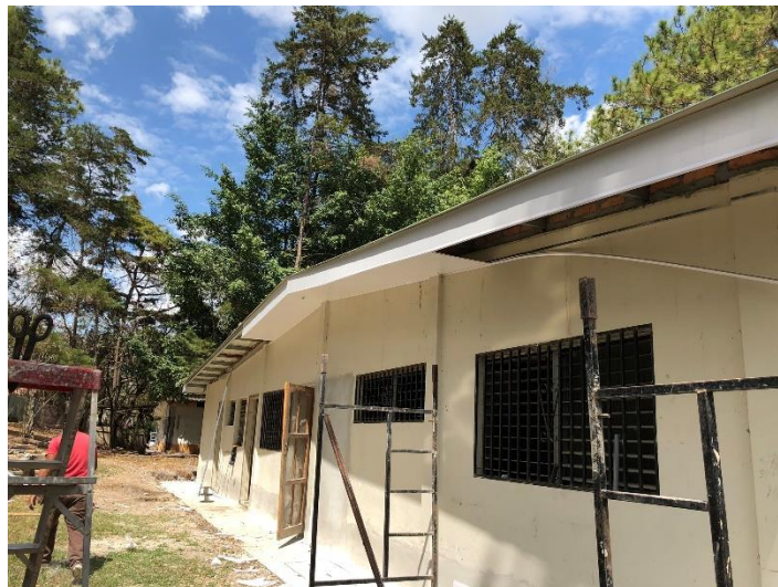
Imagen 2. Instalación de Fascia
