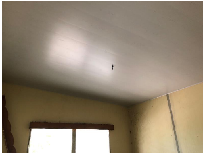
Imagen 3. Cielo Falso Instalado
