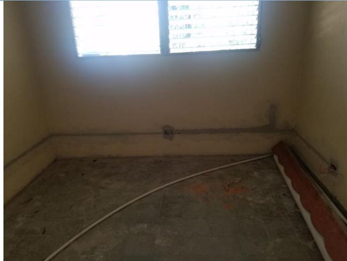
Imagen 7. Repello de parte inferior de paredes exteriores.
