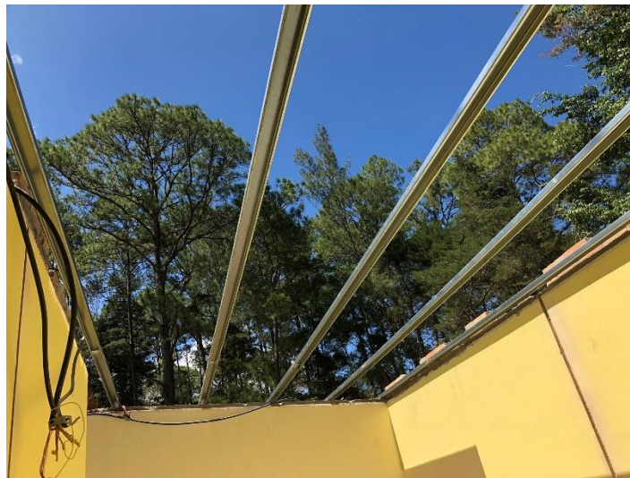
Imagen 12. Estructura de Techo en interiores
