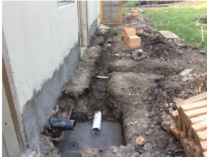
Imagen 9. Excavación, aterrado y suministro e instalación de tubería de 4"
