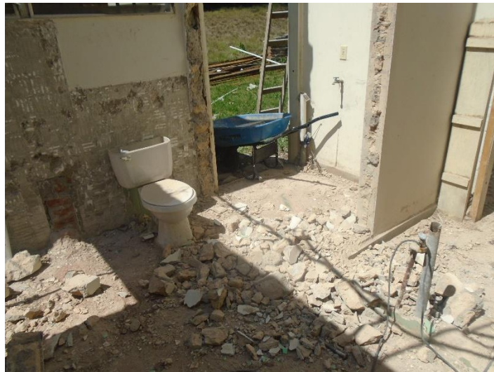
Imagen 4. Eliminación del sistema eléctrico
