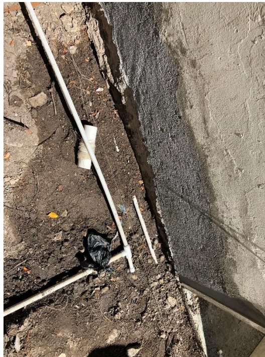
Imagen 10. Suministro e instalación de tubería de ½" AP
