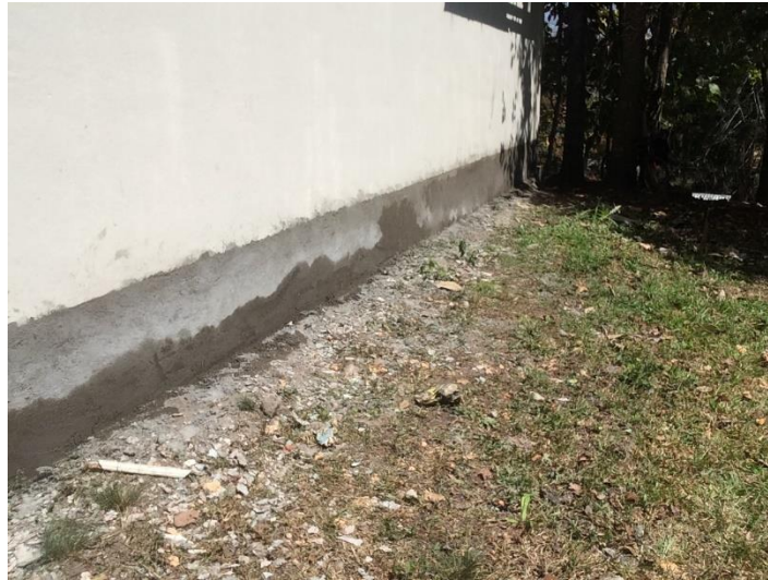
Imagen 13. Repello de parte inferior de paredes exteriores.
