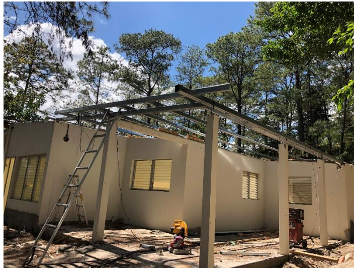
Imagen 12. Estructura de Techo en garaje.
