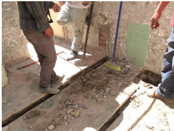
Imagen 8. Picado de firme e instalación de tuberías de 2"
