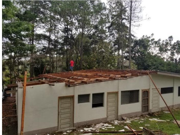
Imagen 1. Desmontaje de Techo y Cielo
