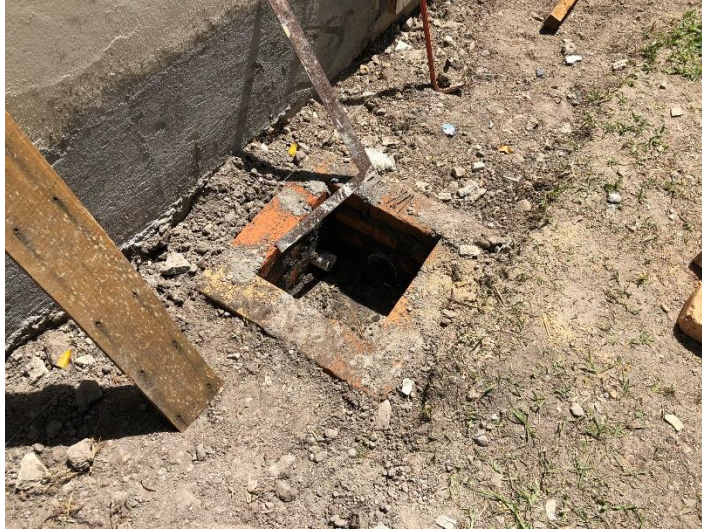
Imagen 11. Construcción de cajas de registro
