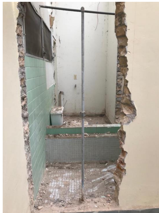
Imagen 2. Demolición de paredes existentes
