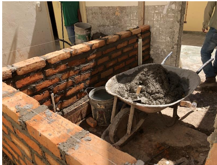
Imagen 6. Paredes en área de ampliación de baños
