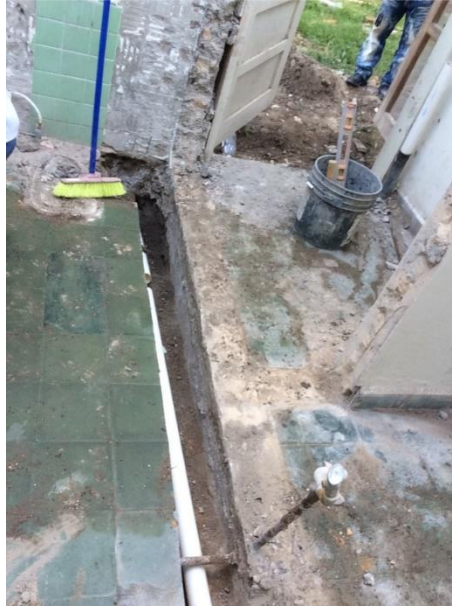
Imagen 7. Picado de firme e instalación de tuberías de 2"
