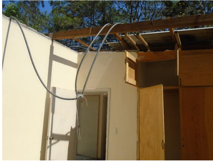
Imagen 3. Eliminación del sistema eléctrico
