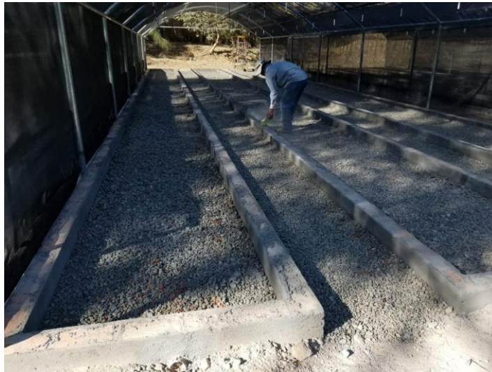
Imagen 4. Bancales con grava triturada y desagües
