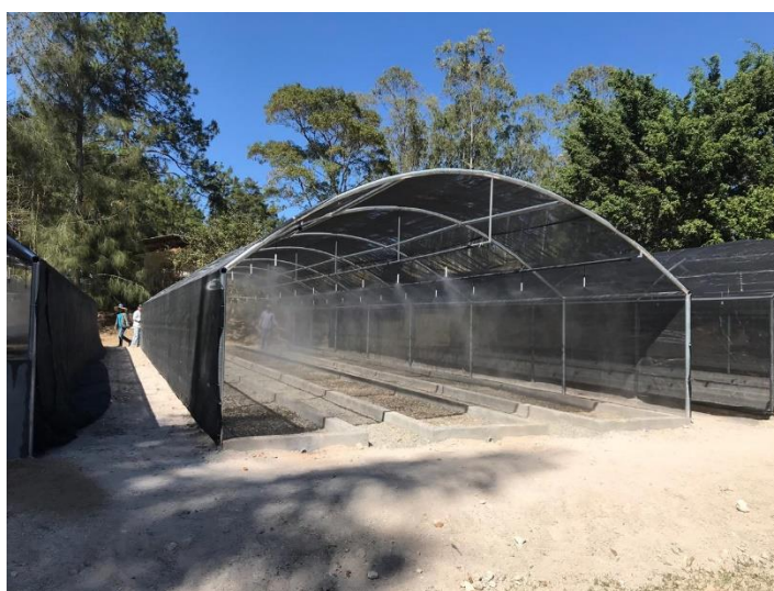
Imagen 11. Prueba de presión del sistema de riego
