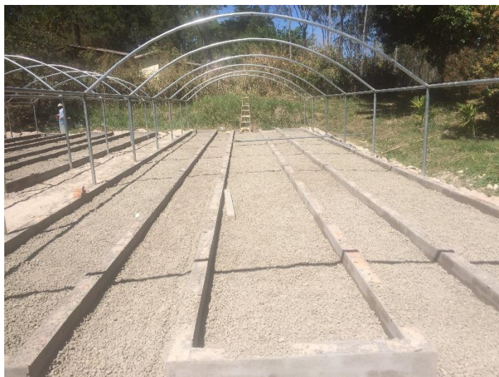
Imagen 2. Soldado de Arco de Tubo Galvanizado en Bancales y Germinador
