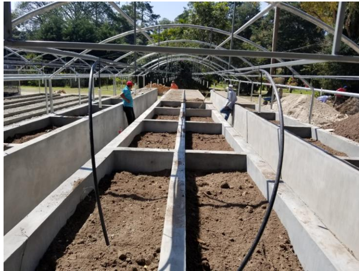
Imagen 6. Germinadores rellenos con la segunda capa de tierra negra.
