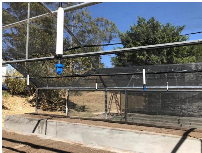
Imagen 8. Sistema de Riego por Nebulización para domo de Germinadores
