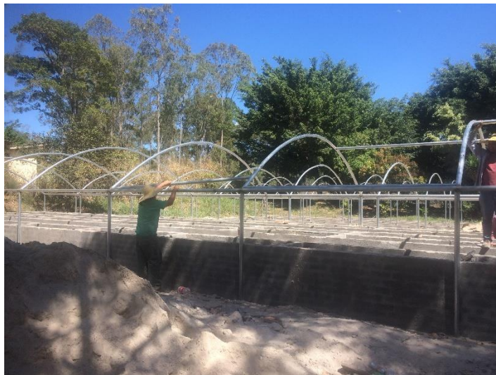
Imagen 1. Soldado de Travesaño T-2 en Bancales y Germinador
