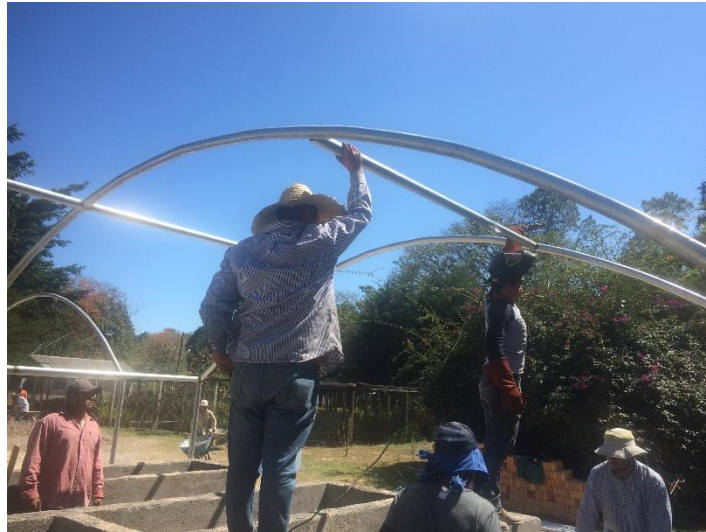
Imagen 3. Refuerzo T-3 de Tubo Galvanizado en Bancales y Germinador
