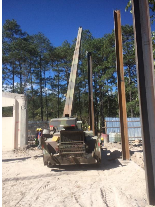
Imagen 6. Grúa sosteniendo Columna Metálica
