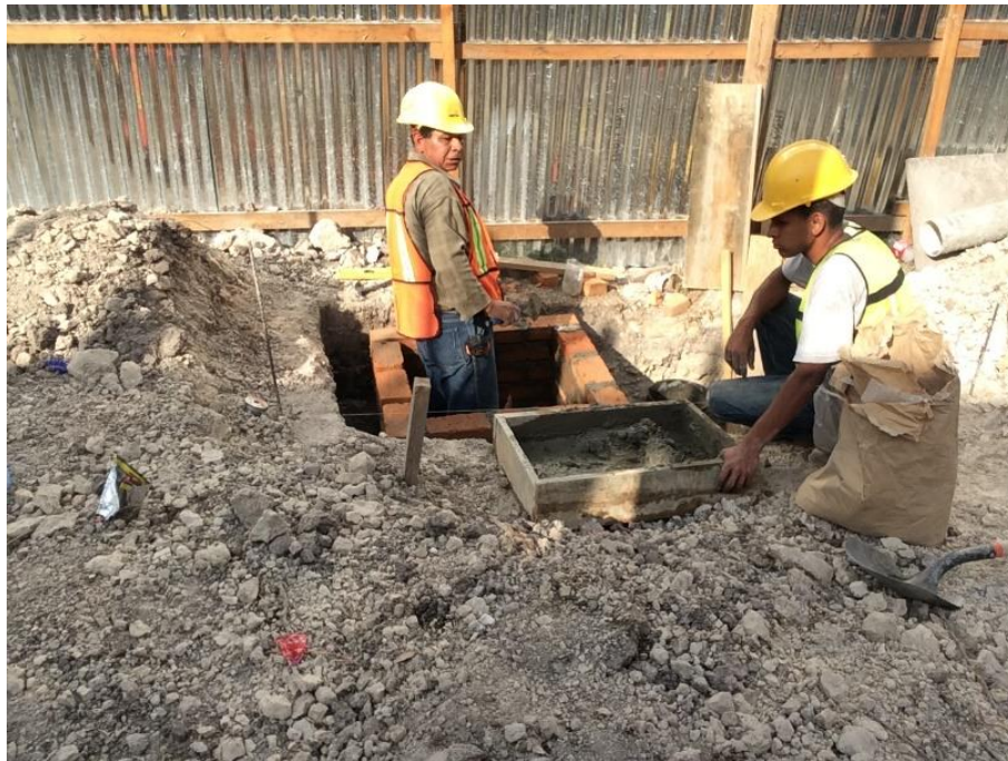
Imagen 10. Construcción de Cajas de Registro de Aguas Negras
