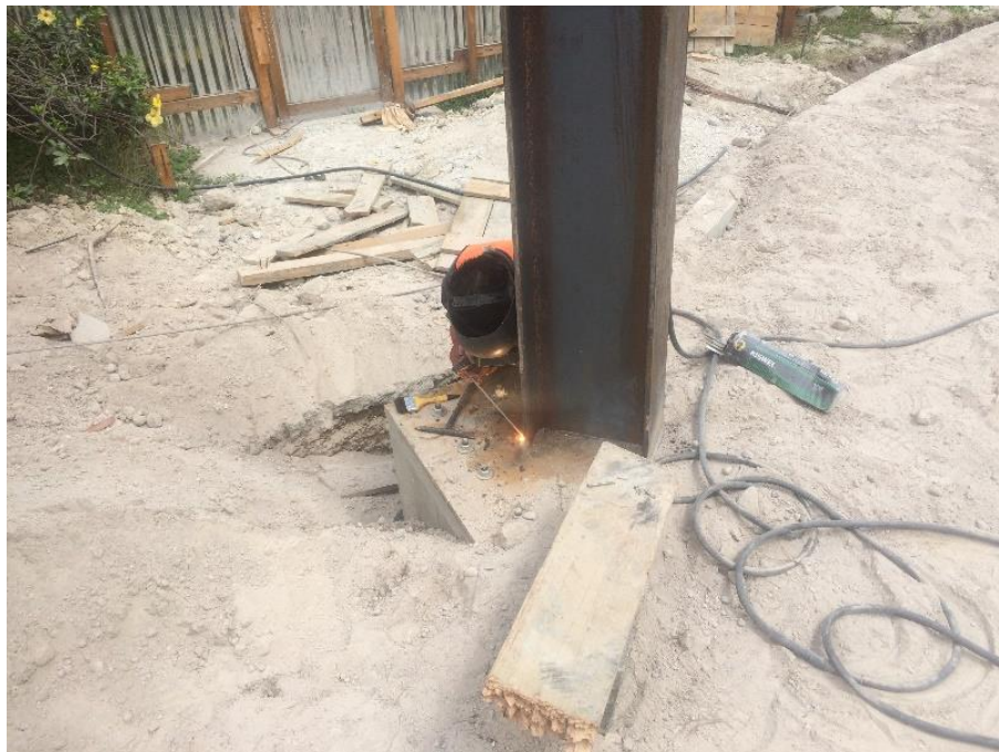
Imagen 7. Soldado de Columnas Metálicas
