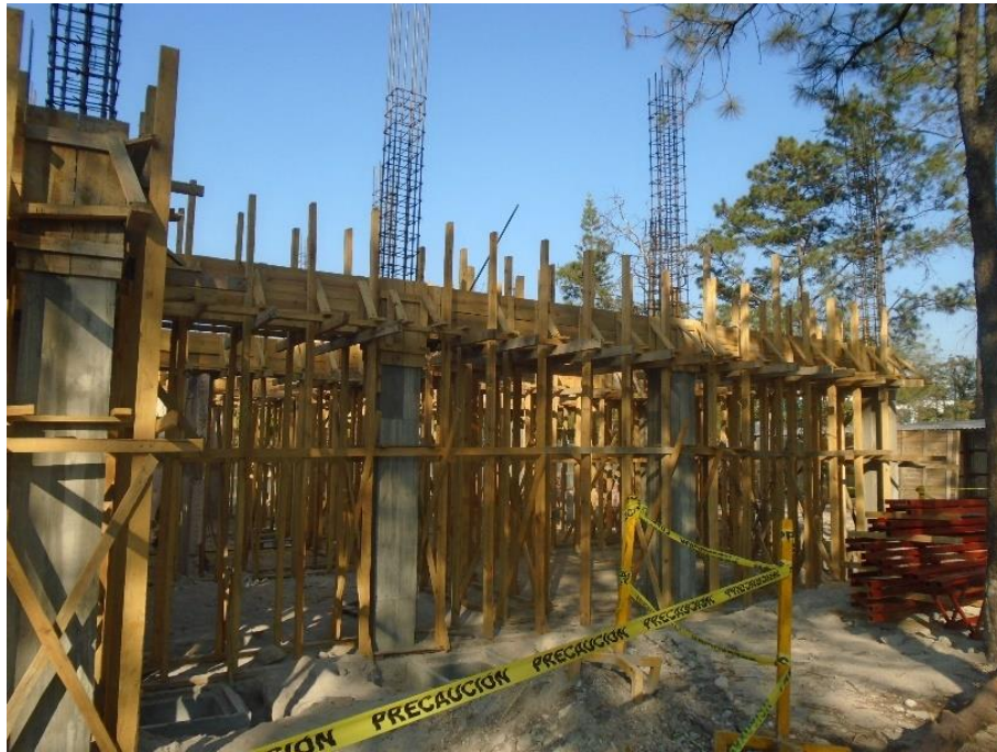
Imagen 1. Piloteado y Encofrado de Vigas
