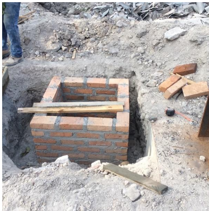
Imagen 11. Construcción de Cajas de Registro de Aguas Lluvias
