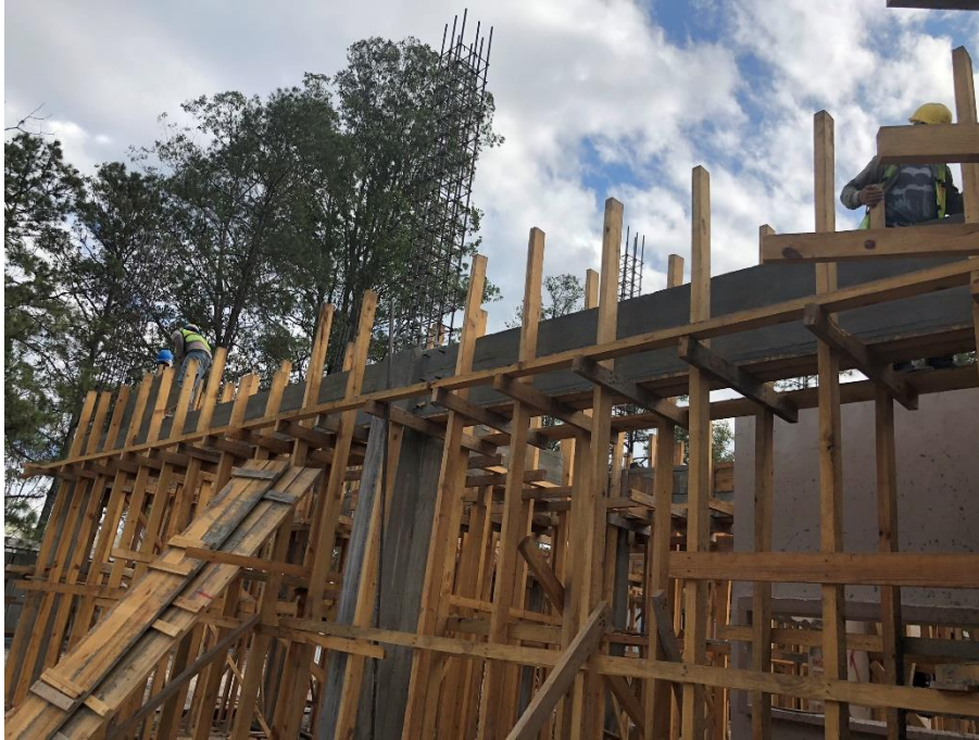
Imagen 5. Vista lateral de vigas fundidas
