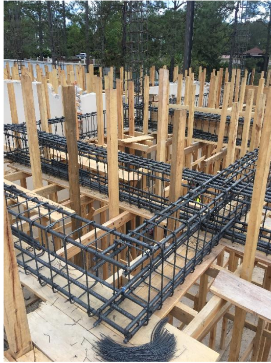
Imagen 3. Armado de Viga V-1 y V-2
