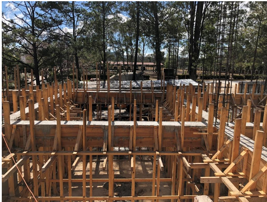
Imagen 4. Vista aérea de vigas fundidas
