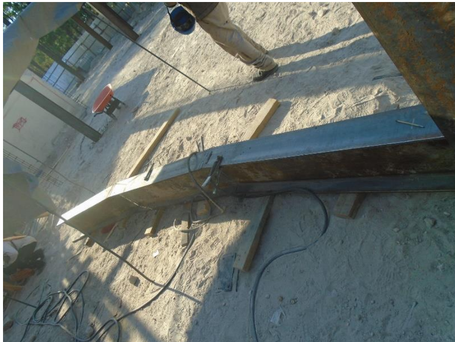
Imagen 9. Soldadura de Vigas Metálicas
