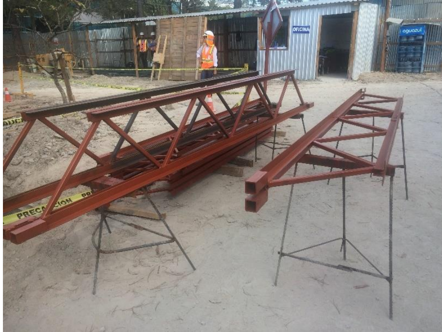
Imagen 8. Armado y pintado de Joist
