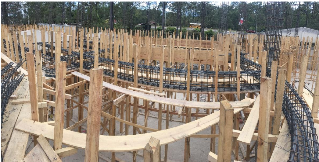
Imagen 2. Armado de Vigas V-2 y V-3
