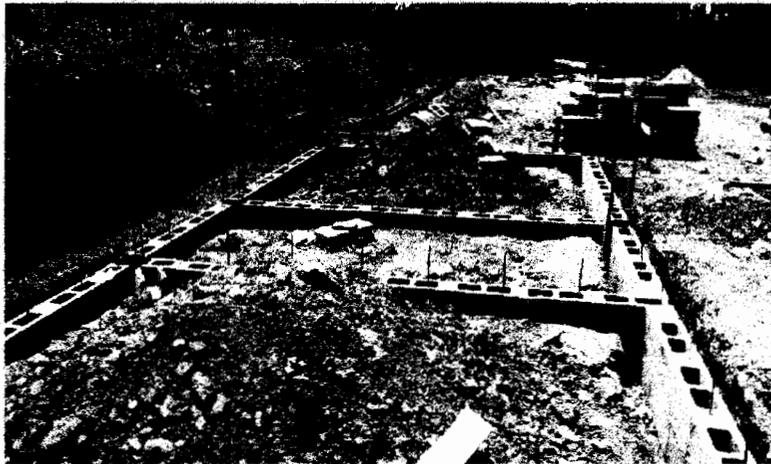
*Fotografía II "Cimentación de Caseta de Mantenimiento de la Planta de Tratamiento de Aguas Residuales"*
