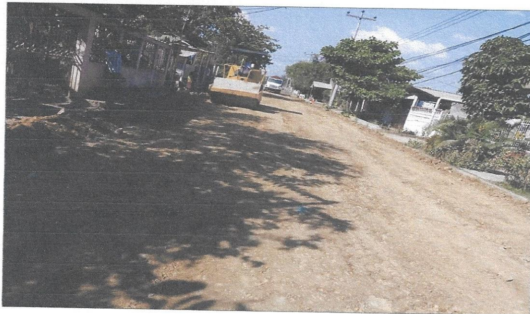
Reparación de calles, Barrio La Victoria Sector Este A del Municipio
