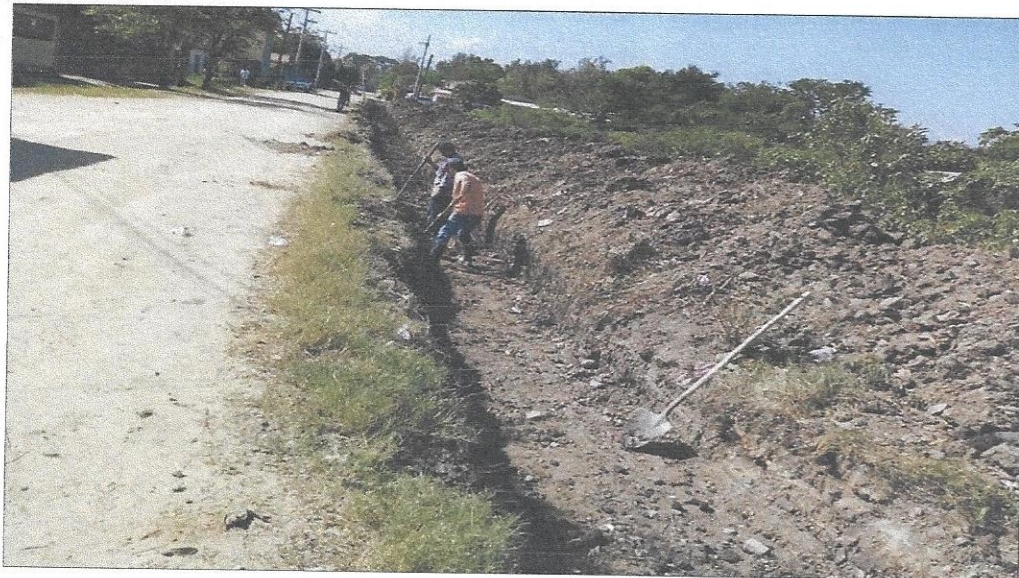
inicio de construcción de enchape de cunetas, Barrio La Victoria Sector Este A del Municipio
