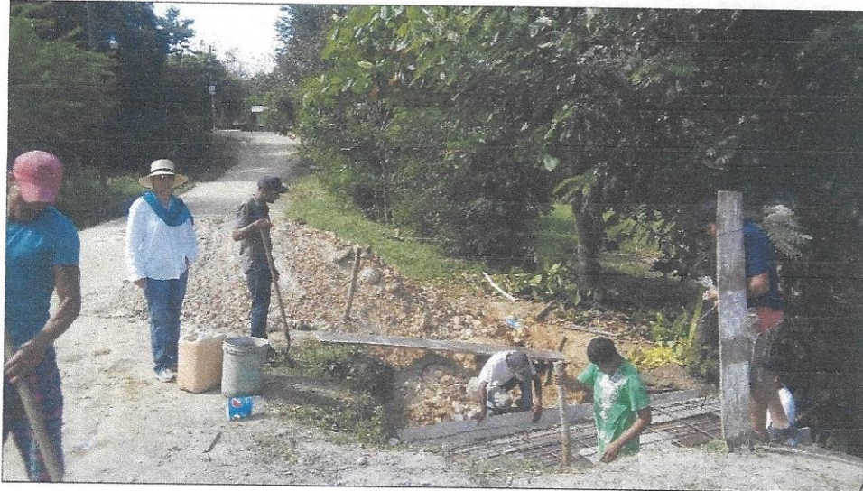
Construcción de Caja puente El Sauce, Participación comunitaria Municipalidad
