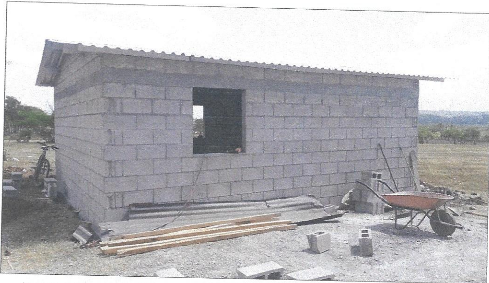
Avances de construcción de viviendas que serán donadas a personas de escasos recursos Colonia Walter Perdomo Sector Oeste C y La Colonia Linda Coello del Sector Perico CEPUDO-MUNICIPALIDAD
