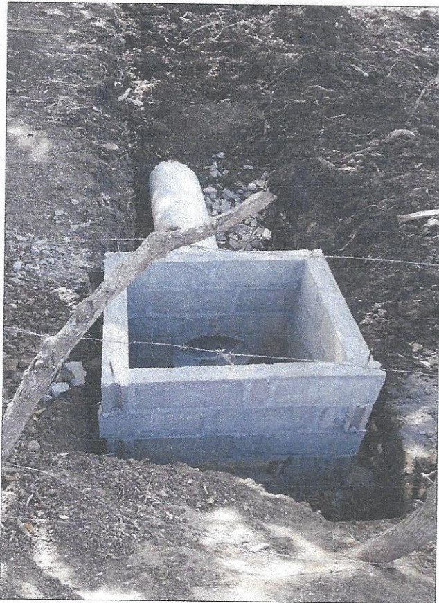
Construcción de caja puente e instalación de tubería para aguas grises y lluvias, Colonia Walter Perdomo sector Oeste C. Municipalidad
