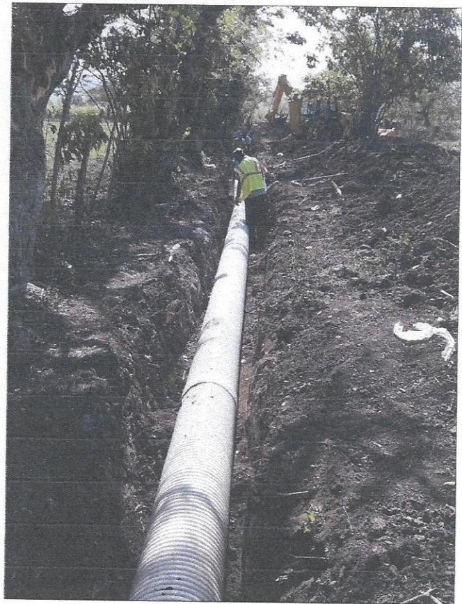
Construcción de caja puente e instalación de tubería para aguas grises y lluvias, Colonia Walter Perdomo sector Oeste C. Municipalidad
