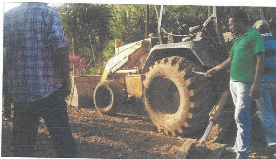
Reparación de calles, Sector El Sauce.
