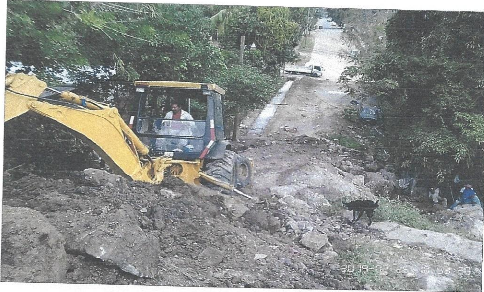
Avances de construcción de cunetas Barrio Las Lomas, Sector Oeste B del Municipio
