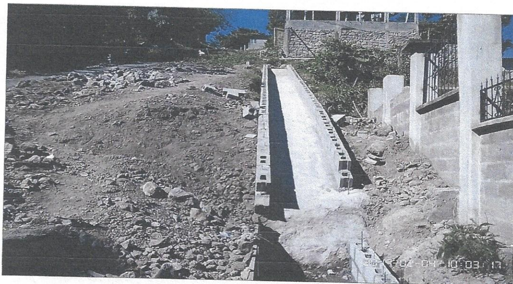
Avances de construcción de cunetas Barrio Tegucigalpa, Sector Oeste B del Municipio
