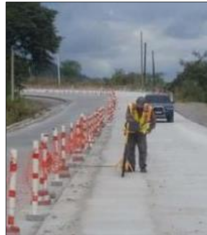
Supervisión del IRI Km 137+315
