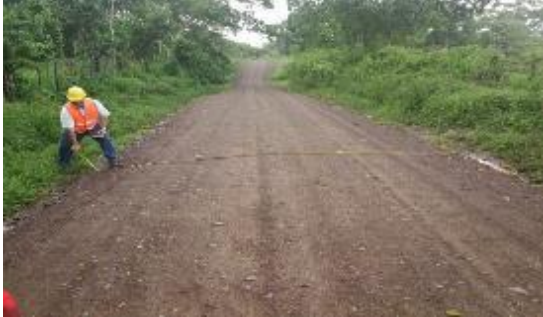
Rehabilitación de tramo carretero Olanchito - El Juncal, en el municipio de Olanchito, departamento de Yoro
