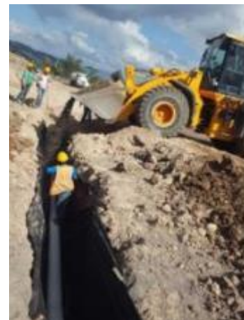
Sub drenaje Est. 25+669
