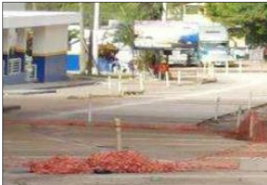
Pavimento concreto hidráulico frontera El Florido
