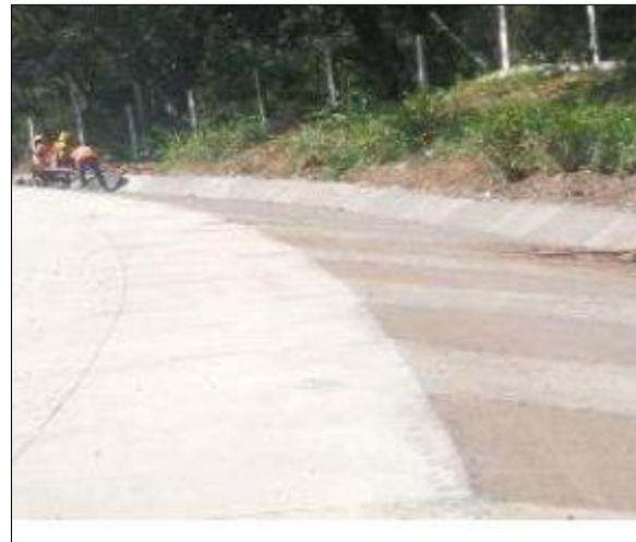
Fundición de cunetas Km46+725
