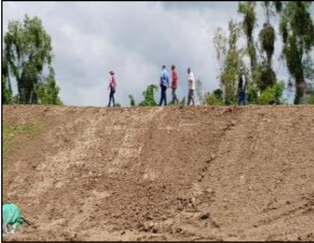
Sobreelevación y Cierre de Boquete, Canal San Carlos, Aldea El Paraíso, La Lima, Cortes
