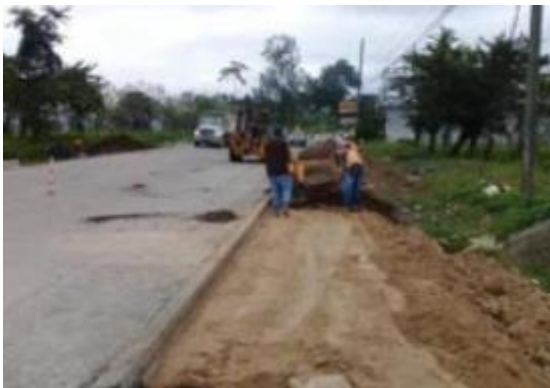
Compactación acera peatonal Km 1+890 LI.
