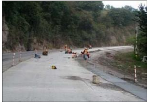
Construcción sobre ancho Km 137.
