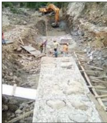
Muro concreto ciclópeo km 107.
