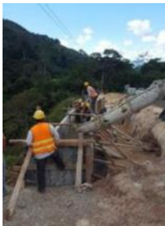
Muro Ludocreto Est. 34+800
