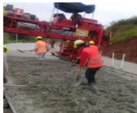
Concreto hidráulico Est. 29+200
