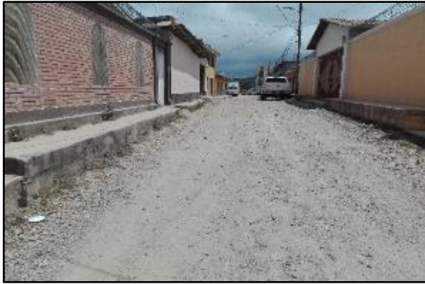
Pavimentación con Concreto Hidráulico de calle en barrio Candelaria, avenida Morera, Municipio de La Esperanza, Departamento de Intibucá. (En movimiento de terracería.)
