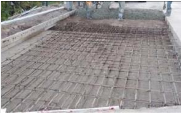
Fundición losa aproximación puente Veracruz
