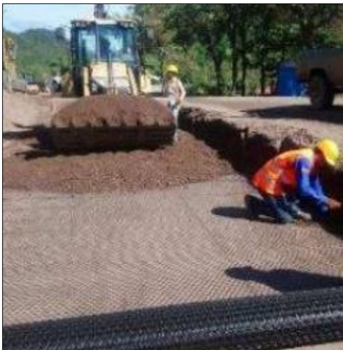
Estabilización usando geomalla en áreas inestables en la subrasante Est. 53+000
