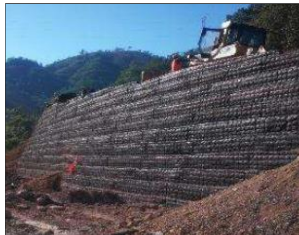
Muro de tierra mecánicamente estabilizado Est. 71+850
