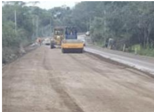
Suelo cemento Est. 21+138 a 31+351 LD
