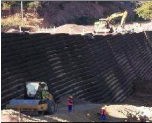
Muro de tierra mecánicamente estabilizado Est.72+000
