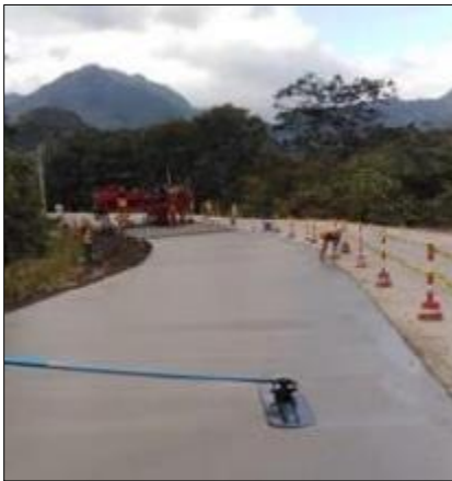
Trabajos de pavimentación. Km 126.8
