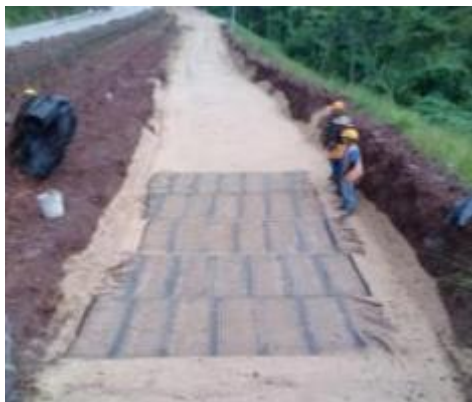
Relleno y compactación muro para estabilización de suelo Est. 35+530 LI
