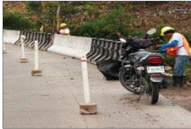
Construcción de barreras New Jersey Est.67+110
