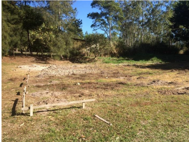
Imagen 1. Trazado y marcado del terreno
