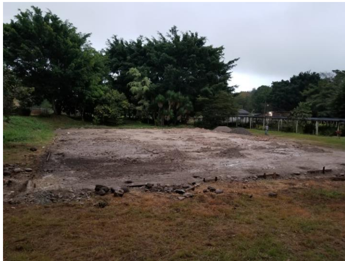
Imagen 3. Nivelación de terreno
