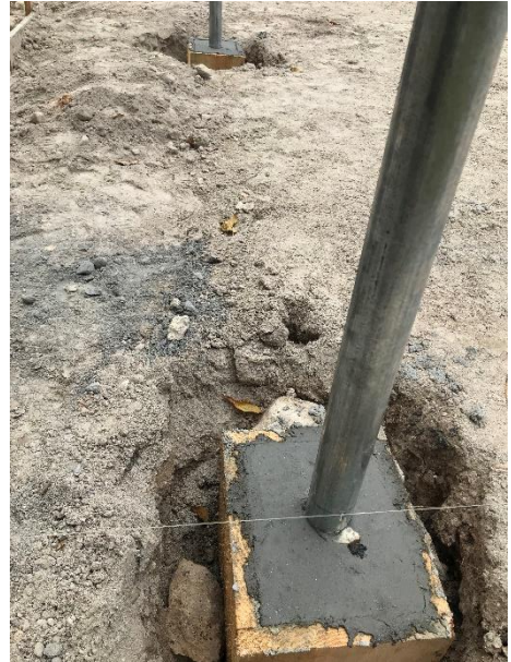
Imagen 8. Fundición de dado de concreto y para vertical
