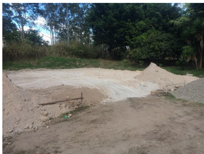
Imagen 4. Relleno y compactado de Material Selecto.
