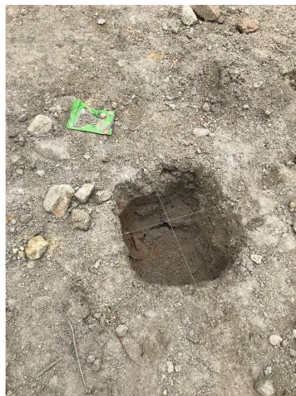
Imagen 6. Excavación para cimentación
