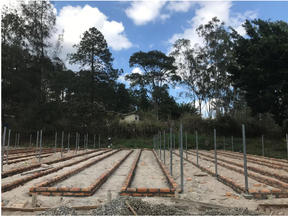
Imagen 11. Construcción de bancales para producción de plantas
