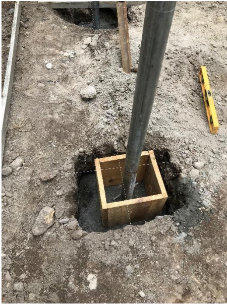
Imagen 7. Encofrado de dado de concreto
