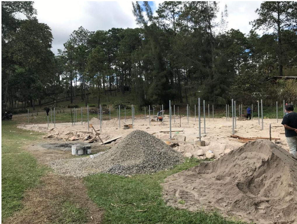
Imagen 9. Fundición de cimentación
