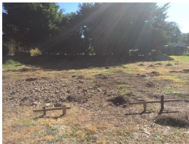
Imagen 2. Trazado y marcado del terreno
