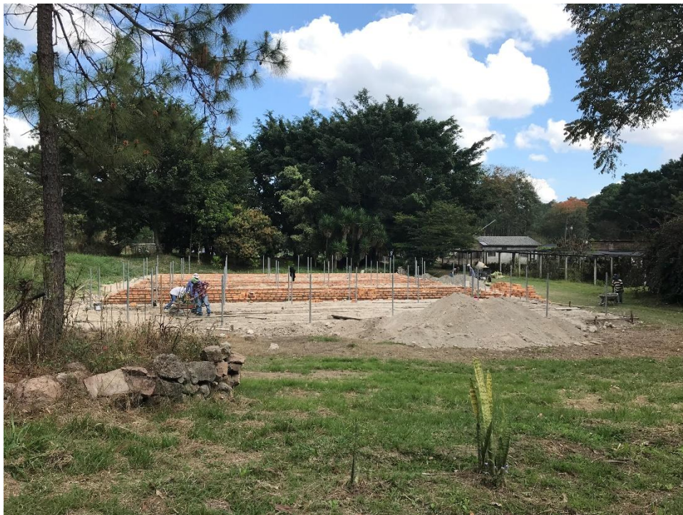
Imagen 12. Construcción de bancales para producción de plantas
