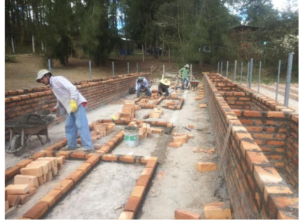
Imagen 14 y 15. Construcción de Bancales para germinador.
