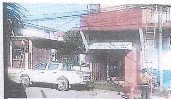
En el área comercial se cambiarán todos los contadores, mientras que en el sector vivienda solo los que estén dañados.
