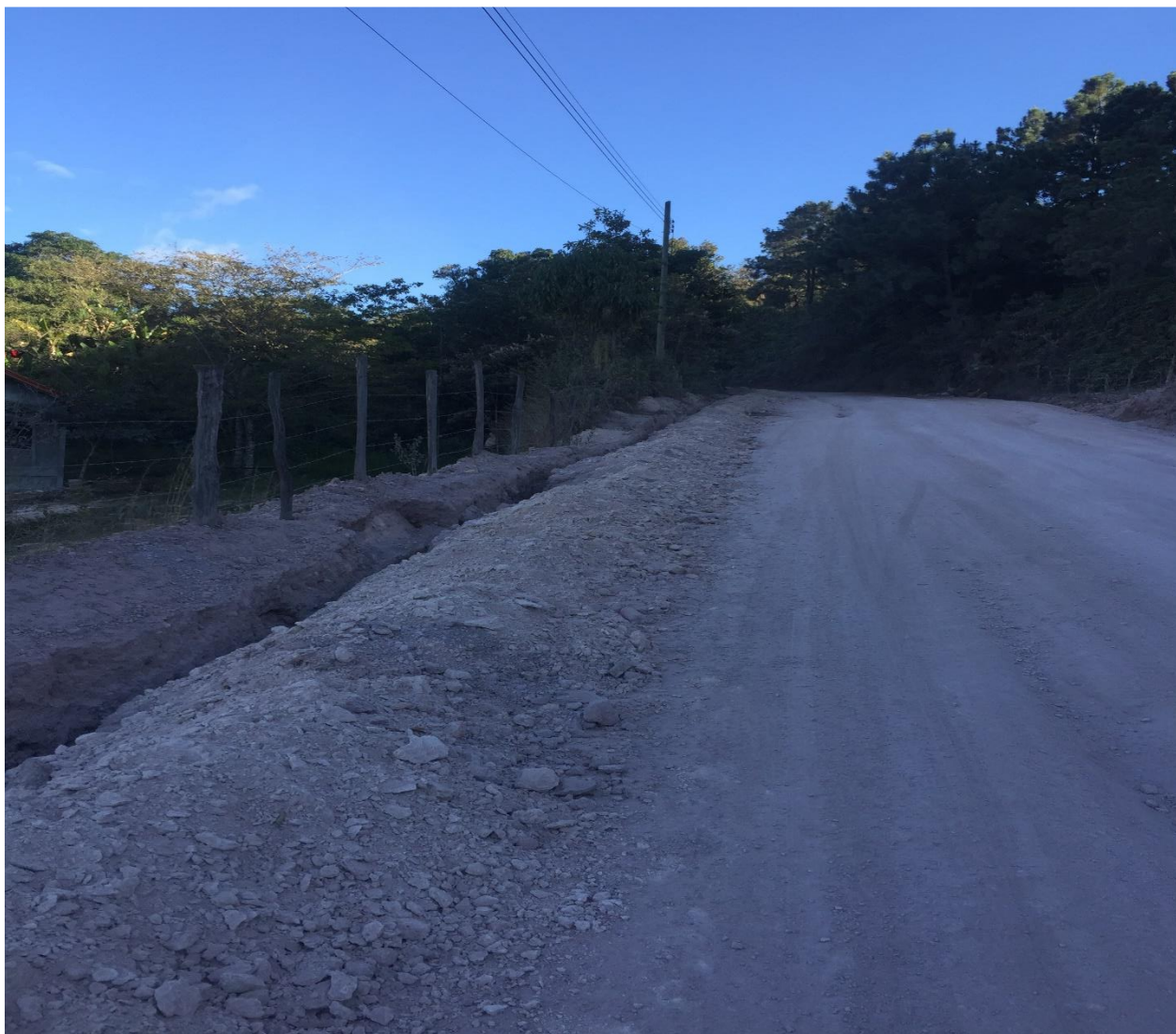
Construcción Red de distribución barrio el portillo
