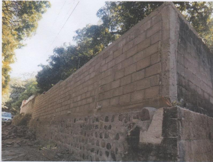
Muro sin tallados
