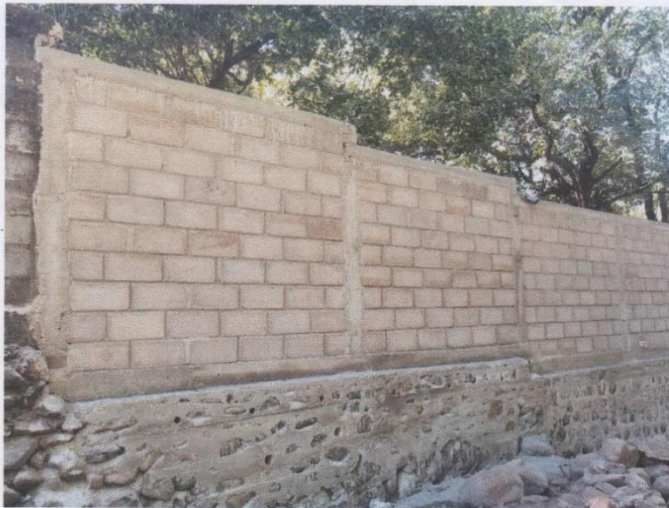
Muro sin tallados
