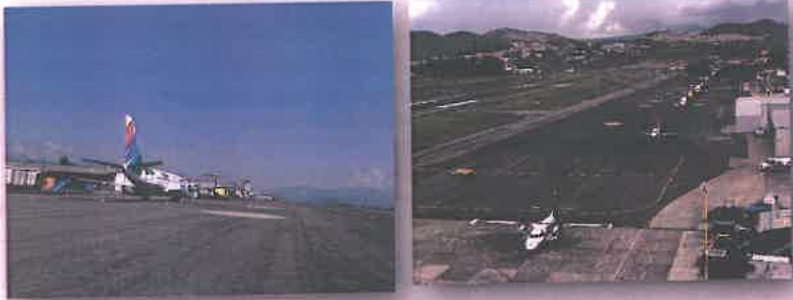
Estado de los pavimentos de las plataformas
