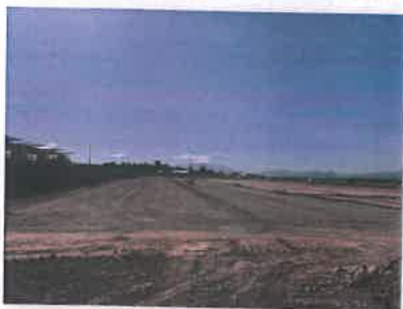
Avance en la subrasante en la Plataforma de Aeronaves
