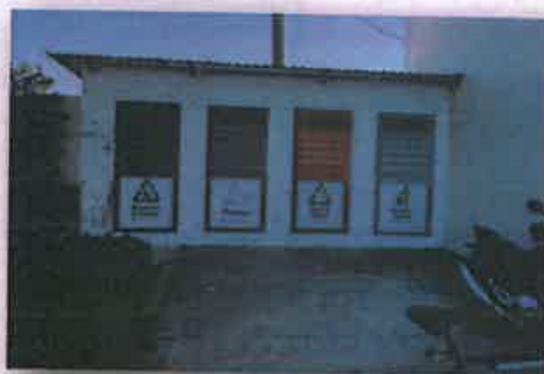
Construcción del nuevo Centro de Recolección de Desechos sólidos
