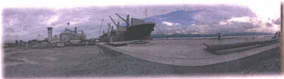
Muelle 3-B Construido hasta el Lado Mar.
