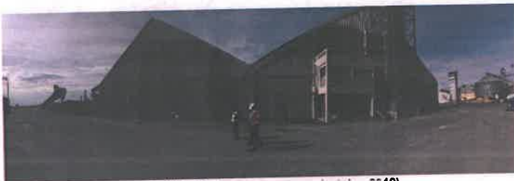
Vista Frontal de la Bodegas (octubre 2018)
