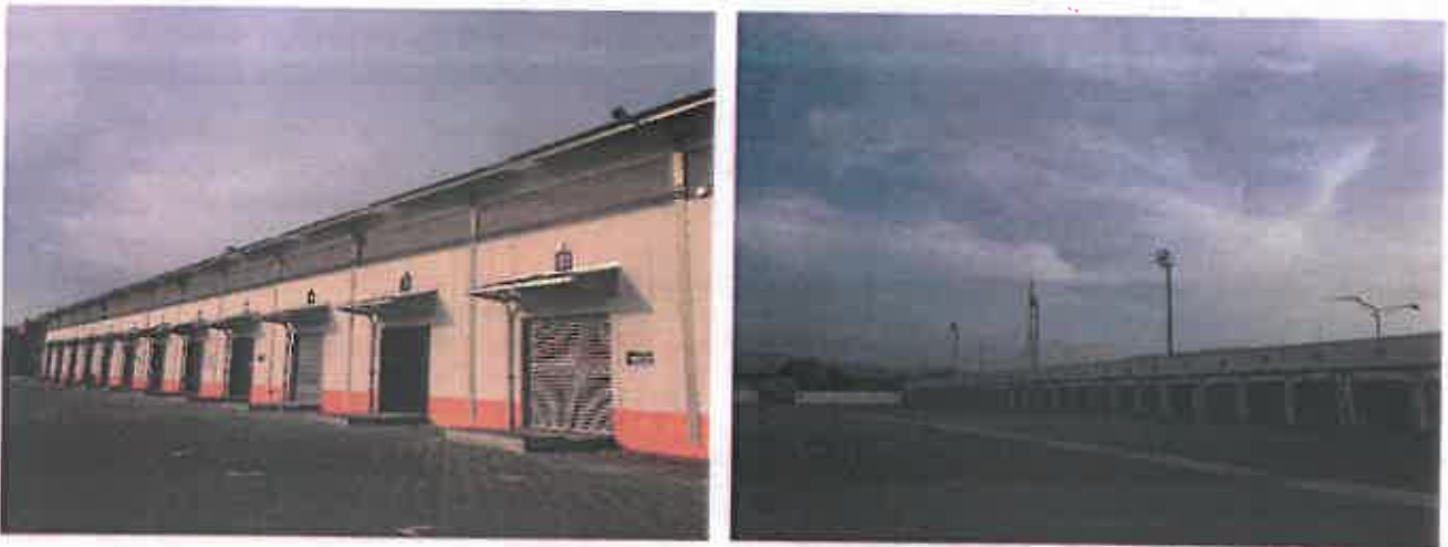
Patio de Revisión de contenedores C7 Terminado y operando.
