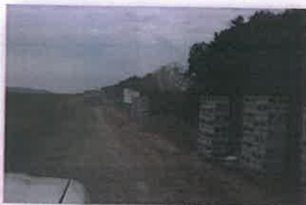
Construcción de cerco perimetral
