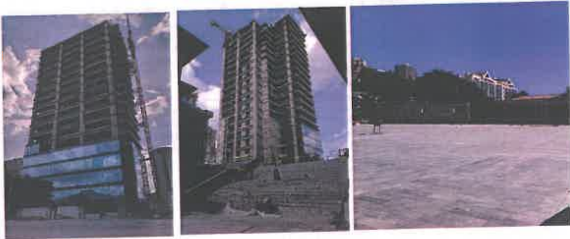
Avance de obras en Torre 01 y Plaza la Democracia.
