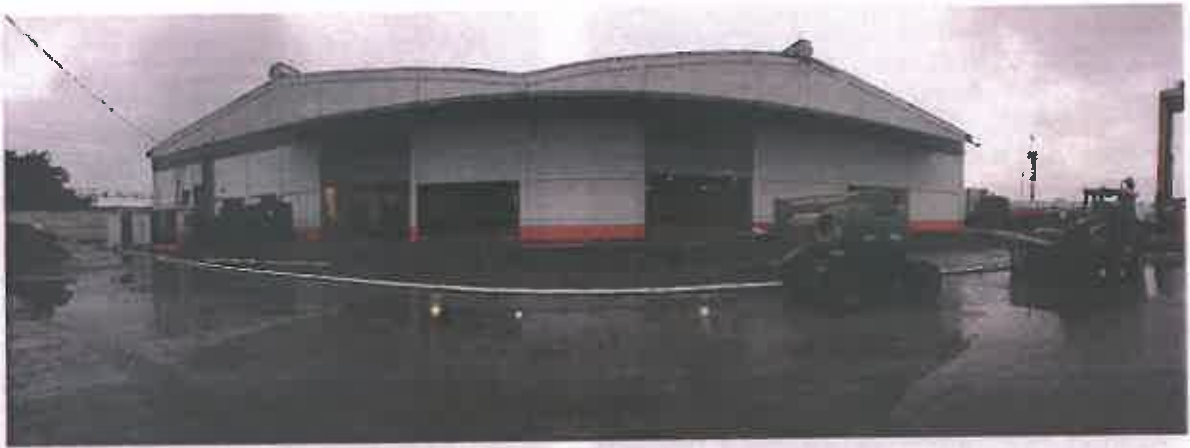
Vista panorámica Patio de Revisión C7.
