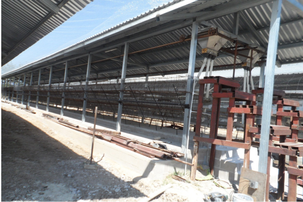
Adecuación de nueva galera para pollas
