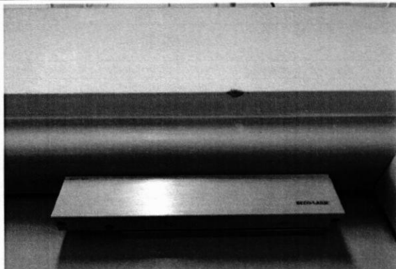
Instalación de cierrapuertas en puertas de aulas.
