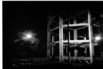
Iluminacion exterior en la zona del Tanque Elevado de 200,000 galones; 31-12-2018
