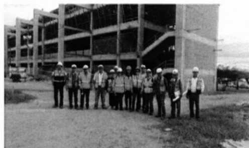
Avance Edificio Aulas No. 1. Vista Panorámica
