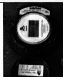
Macromedidor de 6"Ø del abastecimiento de Agua; 31-12-2018
