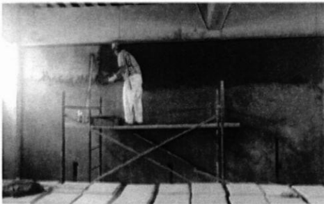
Avance en repello de paredes
