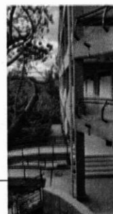
Vista lateral del edificio Anexo C1
