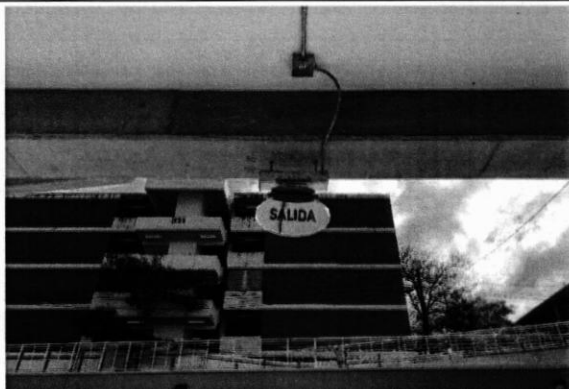
Instalación de lámparas de salida.
