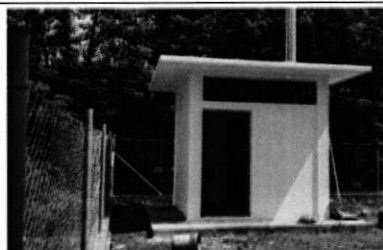
Cuarto de Control de Instalaciones Electricas.
