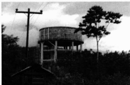
Vista General del Tanque Elevado de 200,000 galones; 31-12-2018
