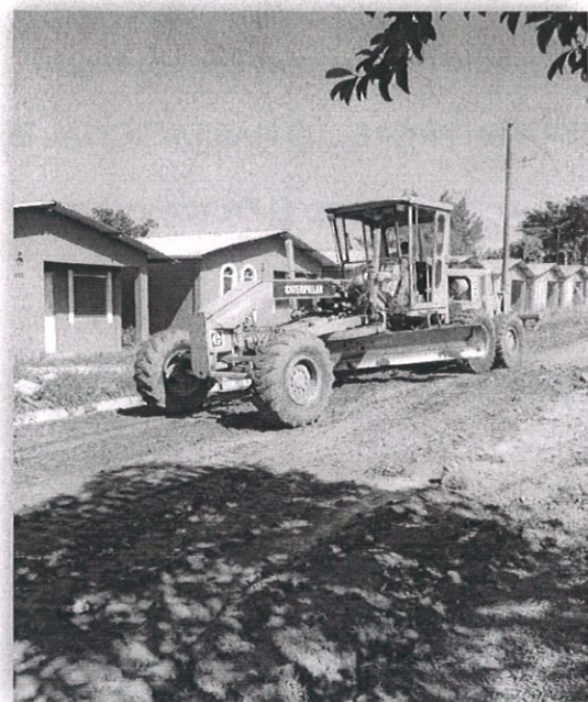
Fotografía III "Motoniveladora utilizada para la escarificación y conformación de las calles"
