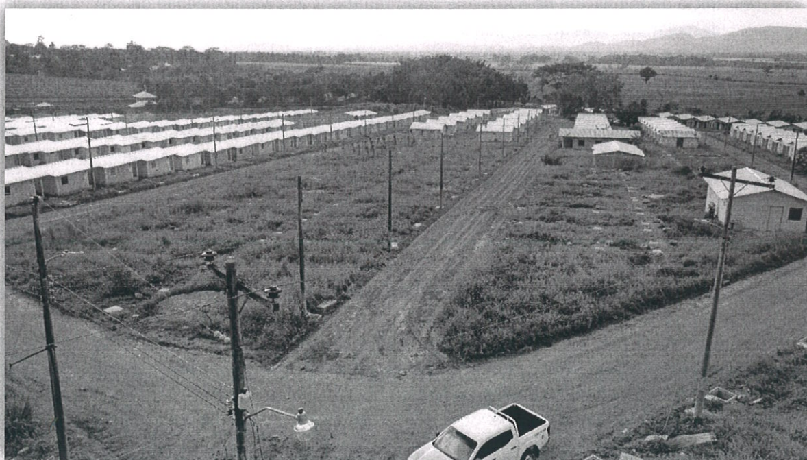
Fotografía XIV "Trazado, desmonte y desbrozo en calles del Proyecto Habitacional"
