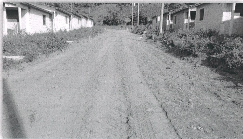
Fotografía XII "Tramo de calle con la actividad de Desmonte y Desbrozo"
