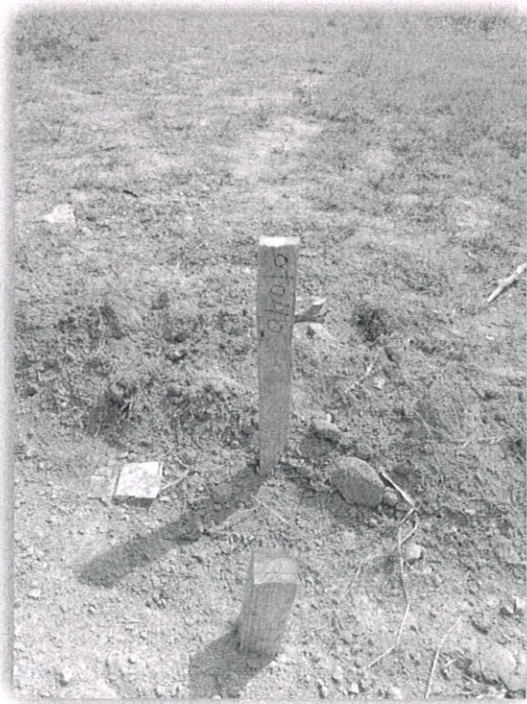
Fotografía VI "Fijación de estacas laterales para efectuar el correcto movimiento de tierras"
