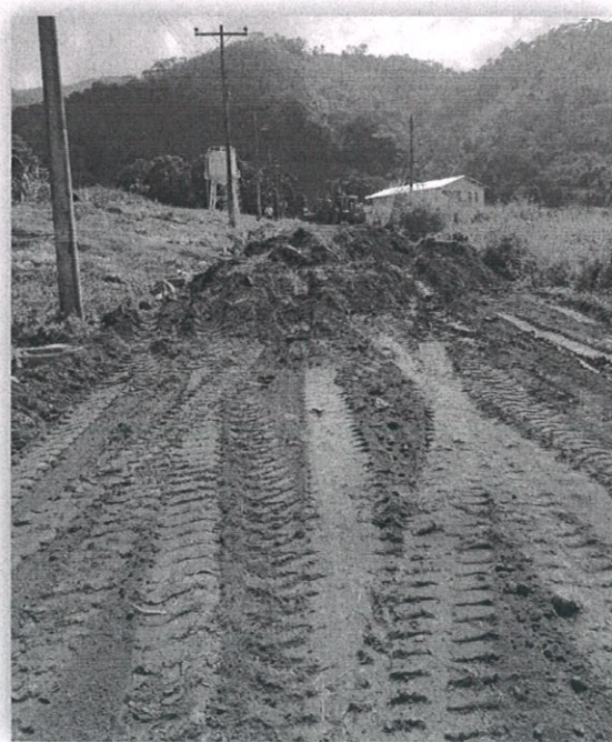
Fotografía IV "Desmonte y desbrozo de los tramos de calle del Proyecto habitacional"
