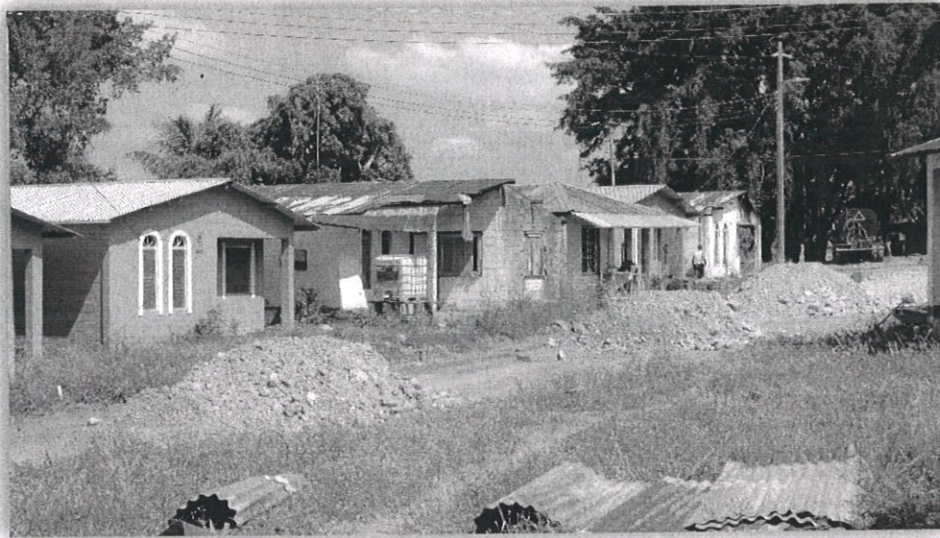
Fotografía IX "Material selecto colocado sobre el tramo de calle"
