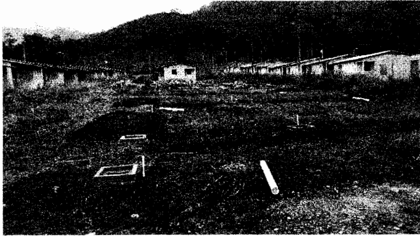
Fotografía VII "Construcción de Cajas de Registro internas en lotes"
