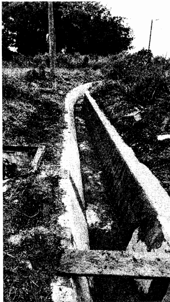
Fotografía VIII "Rehabilitación de Cunetas"
