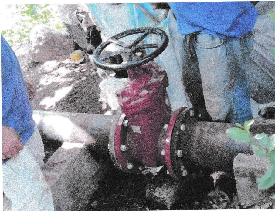
9. Cambio de válvula de 3" en bomba de 7.5 HP en el Pozo El Calan.
