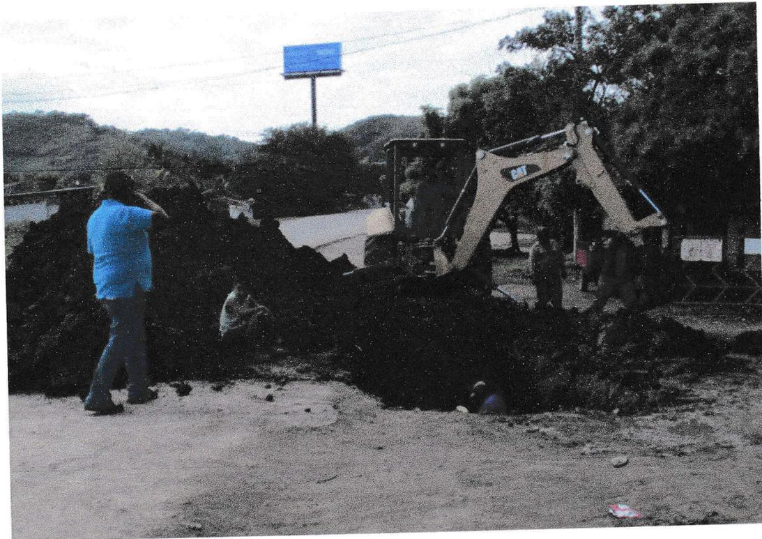
2. Reparación de tubería de 4" en La Mina.
