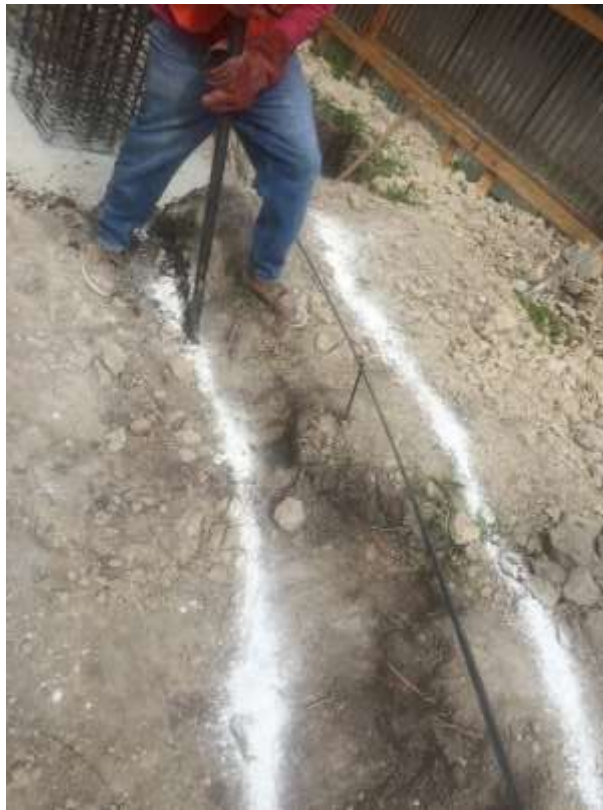
Imagen 1. Excavación de Zapata Corrida
