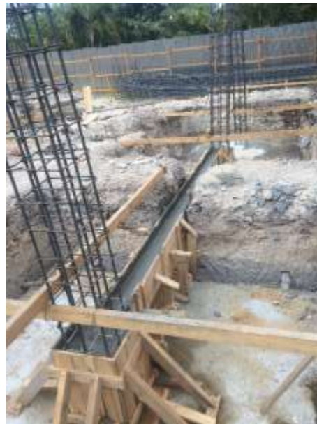
Imagen 4. Fundición de Viga Tensora
