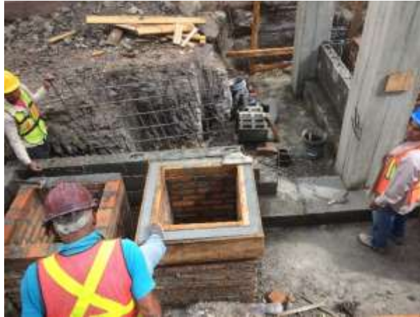
Imagen 12. Construcción de Cajas de Registro
