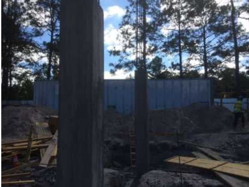
Imagen 11. Columnas Fundidas C-1
