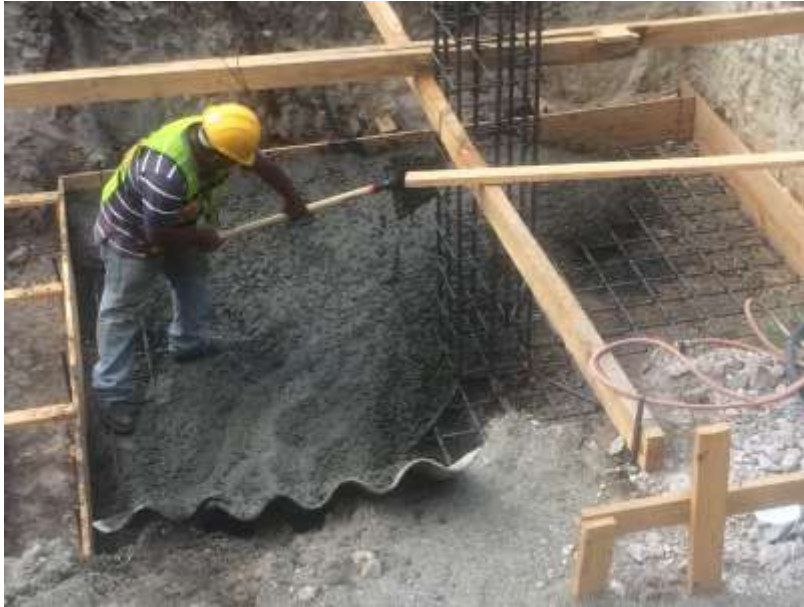
Imagen 3. Fundición de Zapata Aislada
