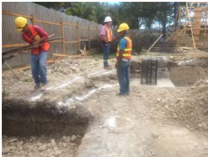
Imagen 2. Excavación de Zapata Corrida
