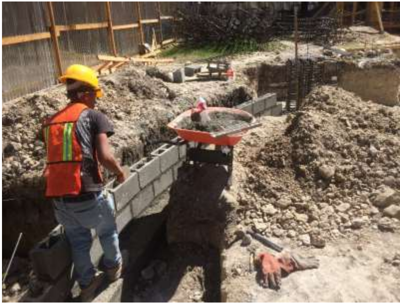
Imagen 7. Sobreelevación de Bloque
