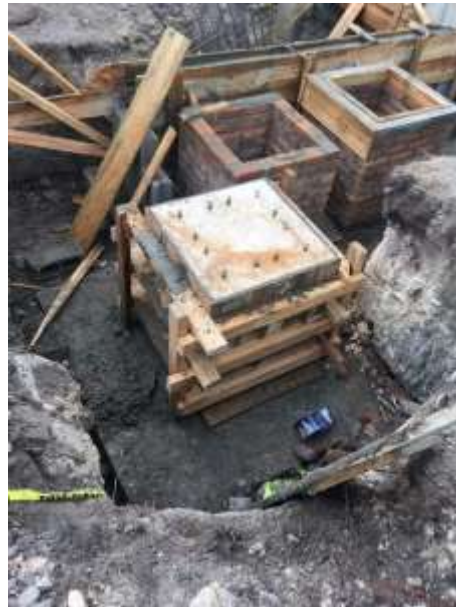
Imagen 5. Fundición de Pedestales
