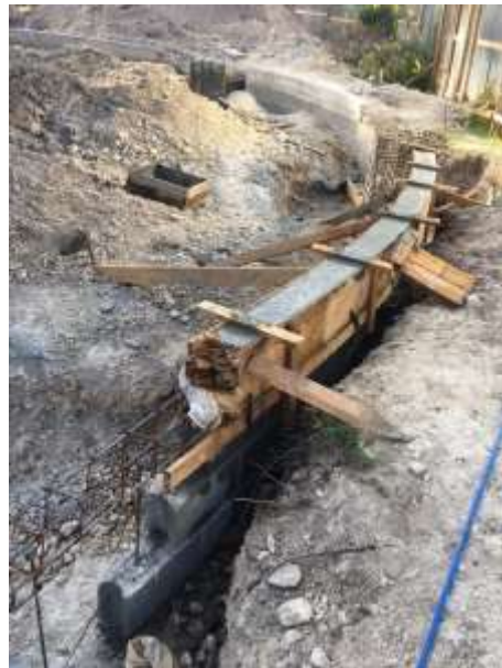
Imagen 8. Fundición de Solera de Humedad
