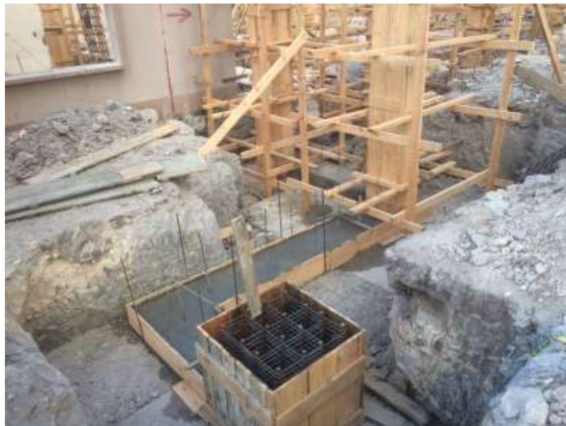
Imagen 6. Fundición de Zapata Corrida, Armado y Encofrado de Pedestales
