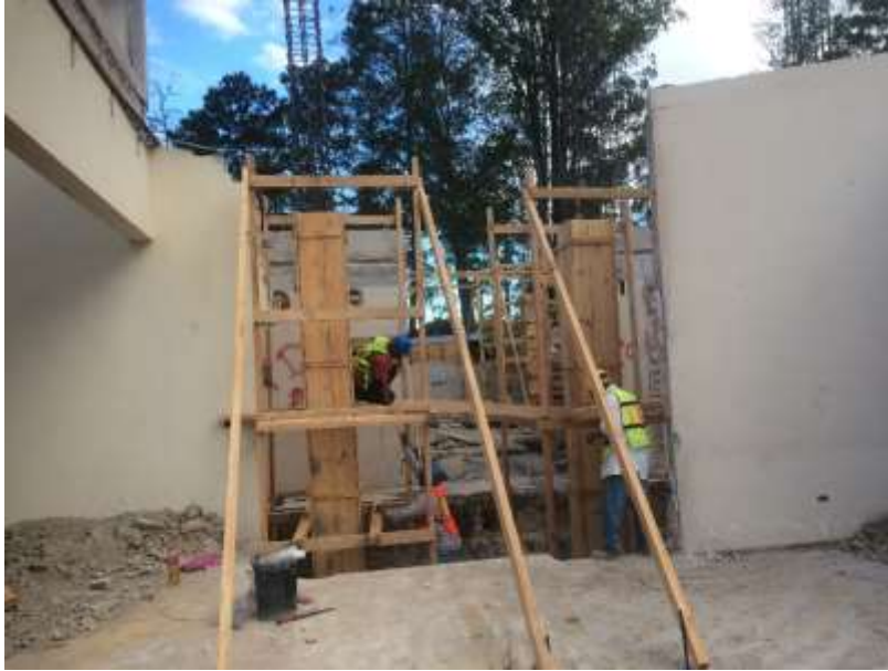
Imagen 9. Encofrado de Columnas C-1
