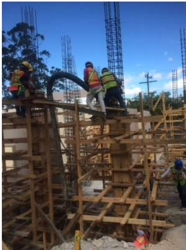
Imagen 10. Fundición de Columnas C-1
