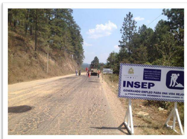
SUPERVISION DE OBRAS
