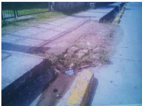
Estructura de concreto que obstruye el canal pluvial.
