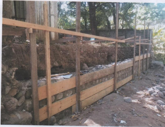
MURO DE CONTENCIÓN
