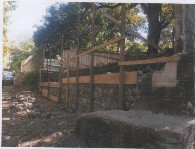
MURO DE CONTENCIÓN
