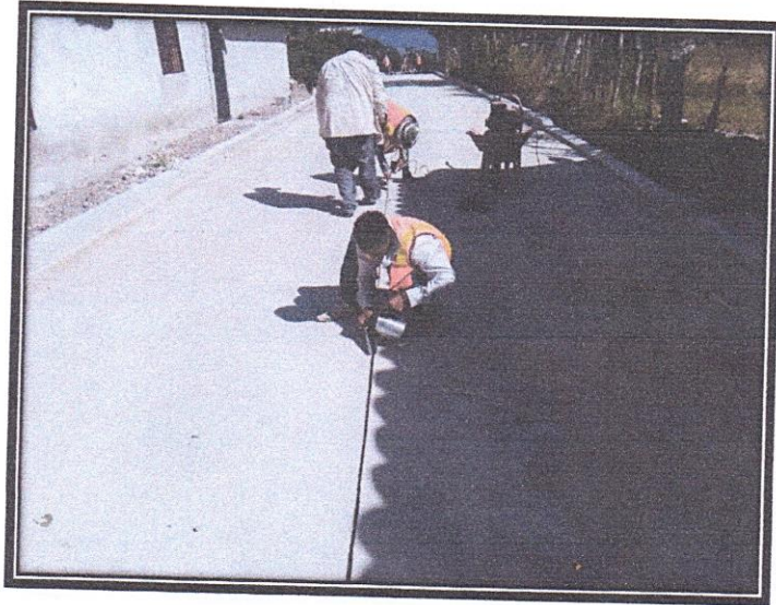
10. Pintura de alto tráfico en bordillos.
