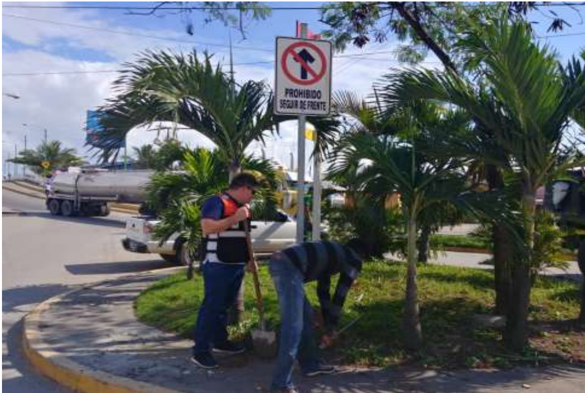
Instalación de señal vertical NO SEGUIR DE FRENTE en B. Porvenir bajando el puente
