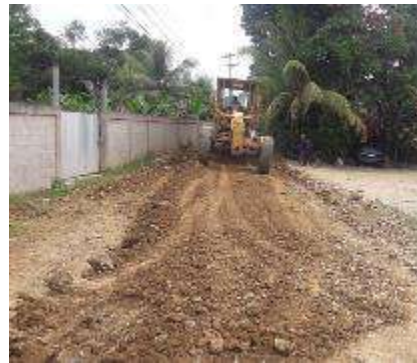
Reparación de calles Sector, Ramal de Lima
