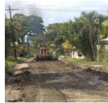
Reparación de calle, Sector Península Este
