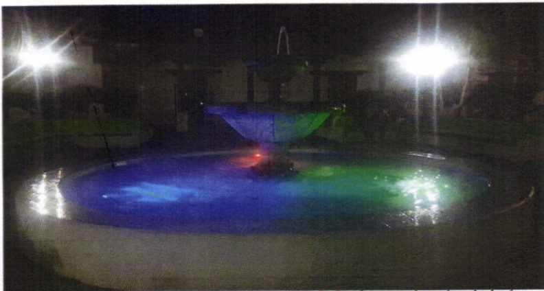
Imágenes muestran la reparación de las luces y bomba de la fuente en la plaza central.
