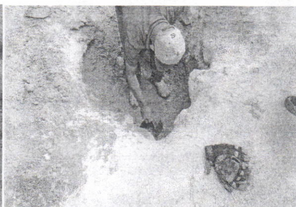
Imágenes, muestra la caja atascada con sedimento y piedra, la tapadera se encontró a 1.5 mts del nivel de la calle.
