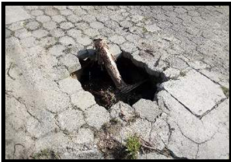
Reparación Adoquinado en Col. Brisas del Mar, Barrio Cienaguita.
