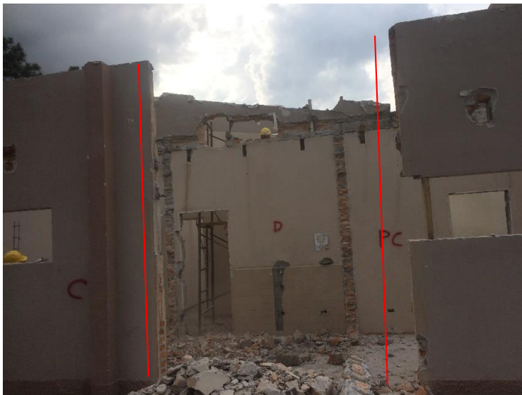
Imagen 3. Guías realizadas con pulidora en demoliciones de paredes.
