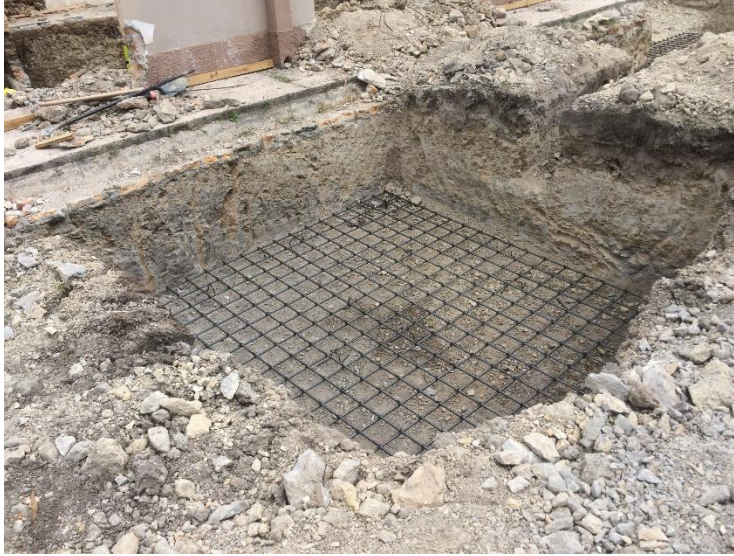
Imagen 14. Parrilla ya colocada. Recubrimiento de 8 cm.
