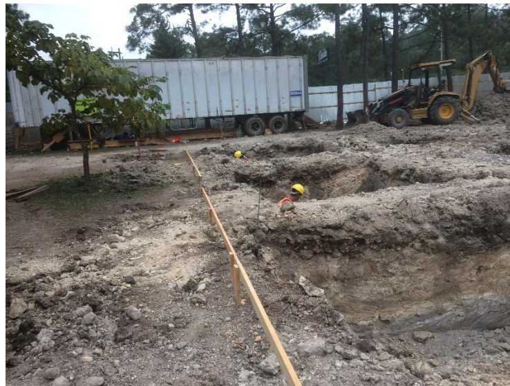
Imagen 11. Trazado, Marcado y Niveleado de Ejes.
