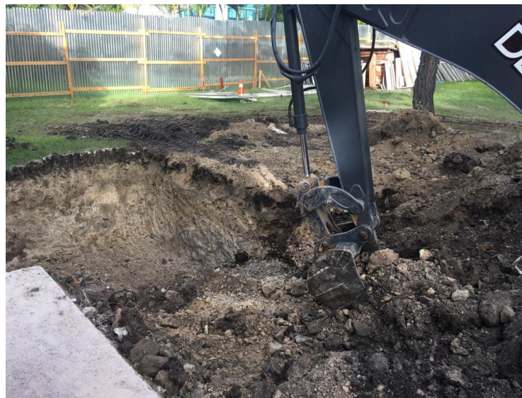
Imagen 12. Excavación con retroexcavadoras.
