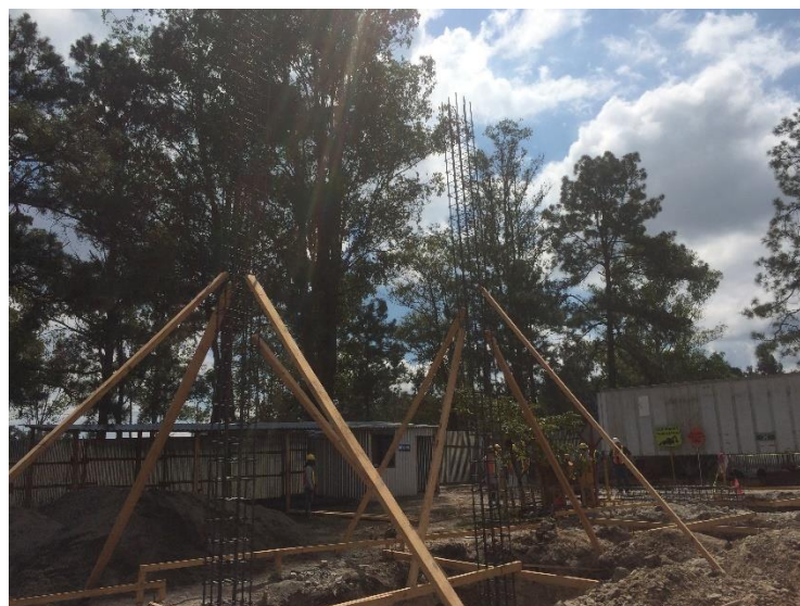
Imagen 18. Armado de Columnas C-1.
