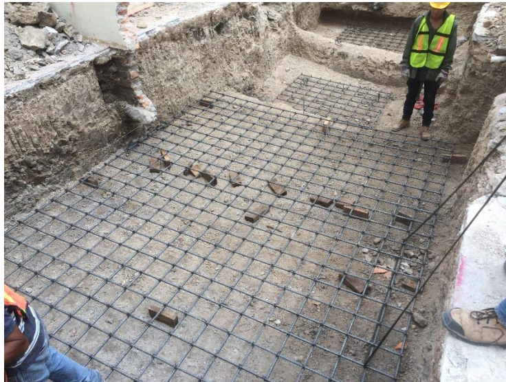
Imagen 14. Colocación de dados provisionales para dar un recubrimiento de 8 cm.
