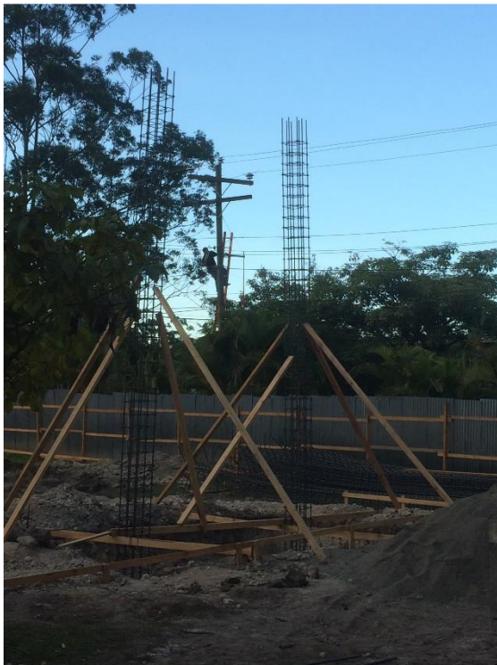
Imagen 16. Armado de Columnas C-1
