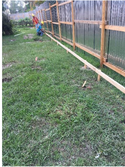
Imagen 10. Trazado, Marcado y Niveleado.
