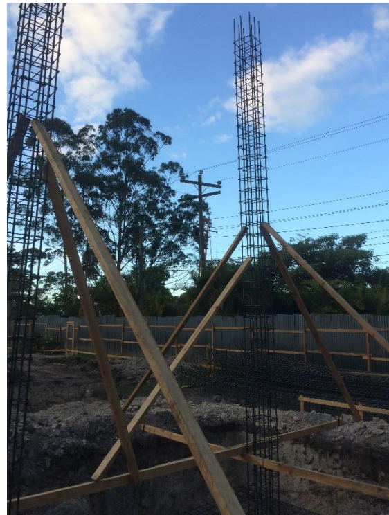
Imagen 17. Armado de Columnas C-1.
