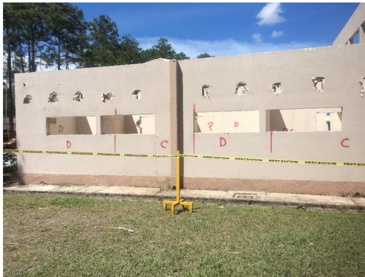
Imagen 1. Marcado de paredes, donde la letra "C" significa Conservar y la letra "D" Demoler.
