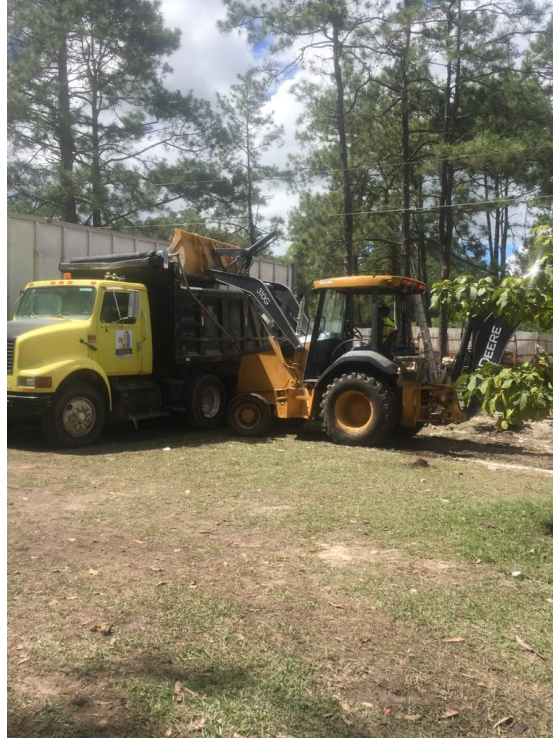
Imagen 6. Cargado de escombros proveniente de las demoliciones de paredes.
