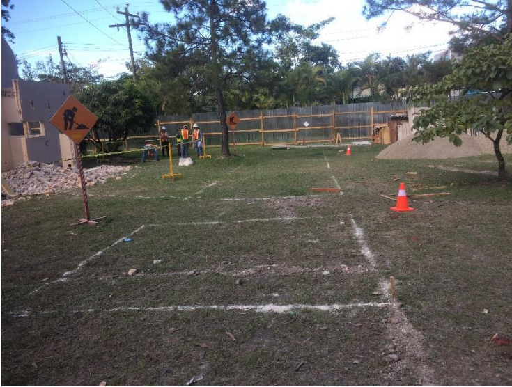
Imagen 11. Trazado, Marcado y Niveleado de Zapatas
