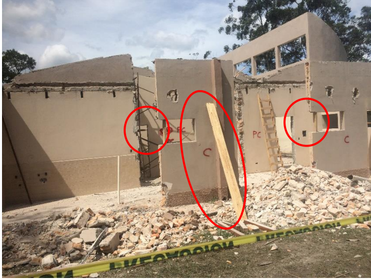
Imagen 2. Apuntalamiento y protección de paredes, para proteger el casco histórico de la UNACIFOR.
