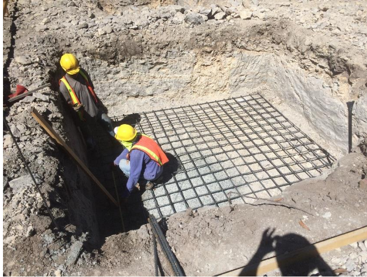
Imagen 13. Colocación de Parrillas de acero #5, grado 60.
