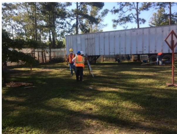
Imagen 8. Marcado de Ejes con Topografía
