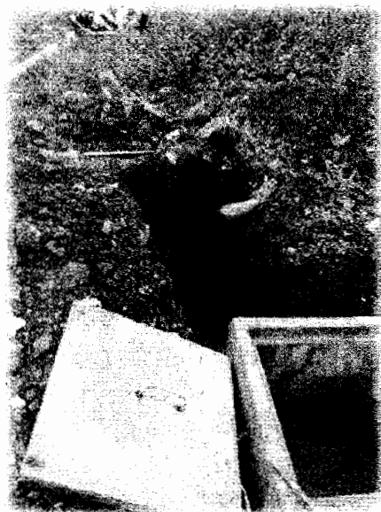
Fotografía XVI "Construcción Cajas Domiciliarias"
