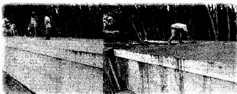
Fotografía VI "Fundición Losa Superior PTAR"
