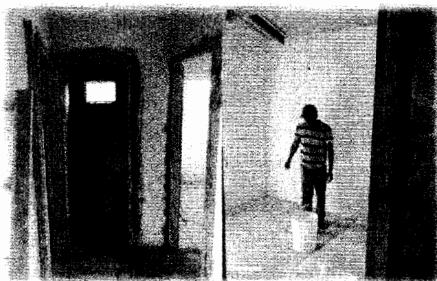
Fotografía X "Instalación de contra marcos, ventanas y celosías, puertas, Así como pintura en paredes interiores (Casa #79 a la #85)"
