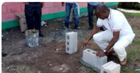
Colocación de Primera Piedra Kinders Porfirio Ruiz Col. Prados de la Misericordia
