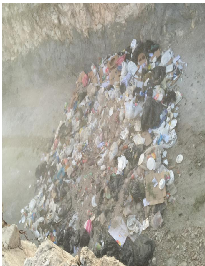
Aplicación de capa de 7 cm de material selecto sobre basura compactada
