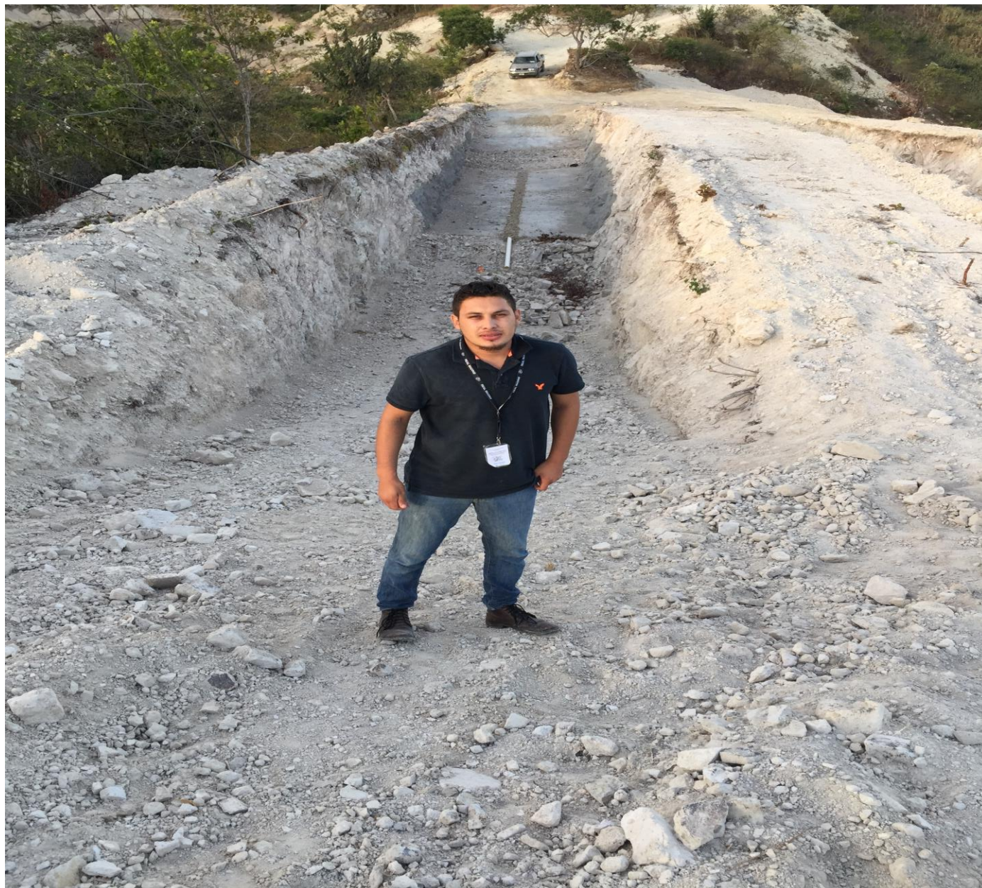
Proceso de construcción de piso, filtro francés y repello en trinchera #1
