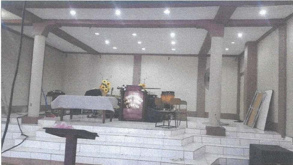
Realizado trabajos de pintura Iglesia Peniel, Colonia 21 de Abril, Sector Este C
