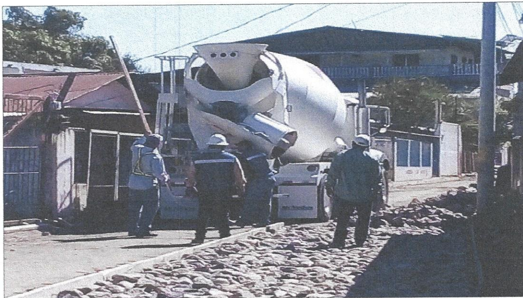
Proyecto Pavimentación Colonia La Unión, Sector Dos Caminos
