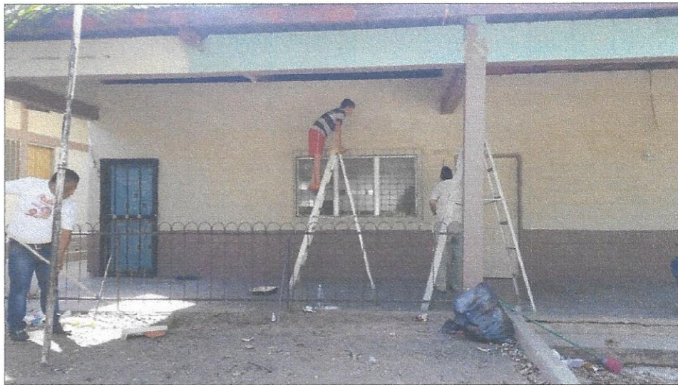
Realizando trabajos de pintura Escuela Rafael Cantarero, Colonia Guadalupe López Sector Este C
