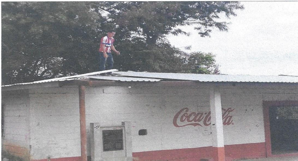
Reparación de techo de Centro Artesanal, Sector Norte
