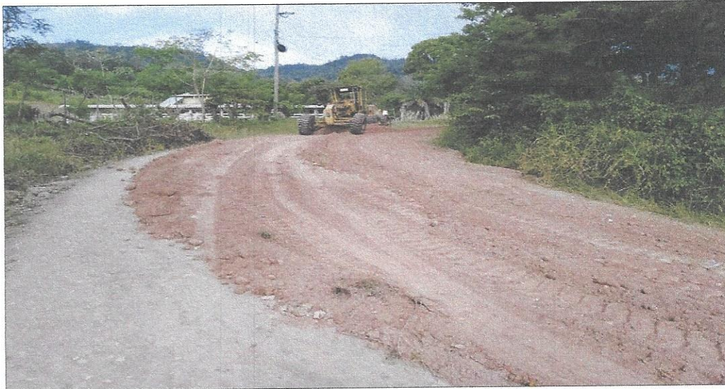
Reparación de calles, Sector Venado
