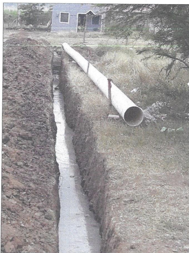
Instalación de tuberías para aguas lluvia, participación ciudadana, CEPUDO y Municipalidad
