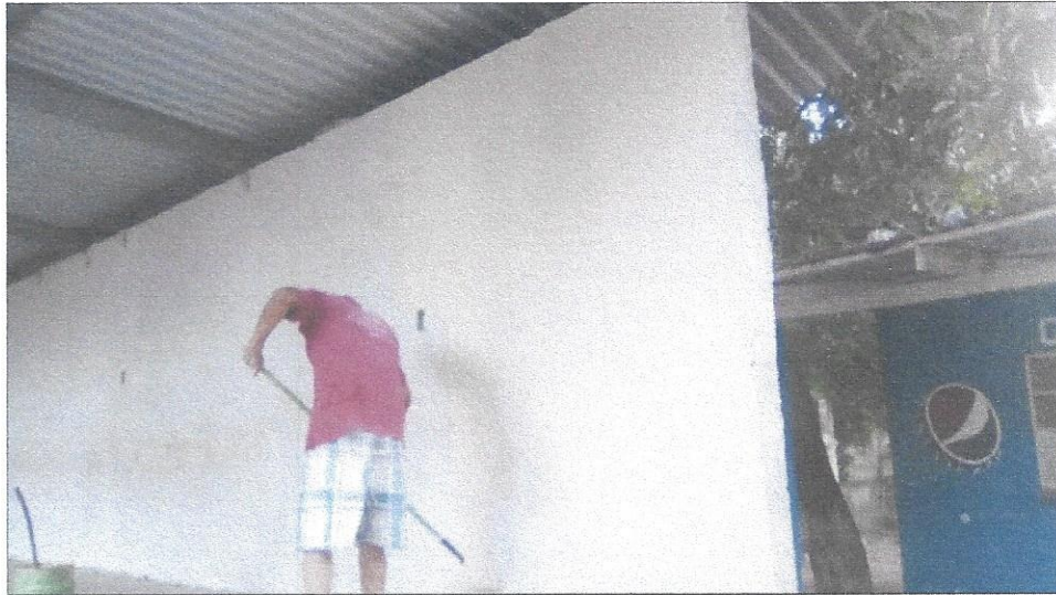
Realizando trabajos de pintura Centro Básico Sector Perico
