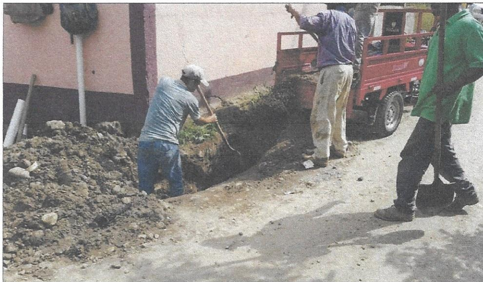
Mantenimiento a tuberías de agua potable, Sector Este C
