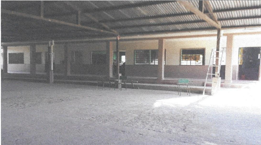
Realizado trabajos de pintura en Centros Educativos, Sector Sinaí
