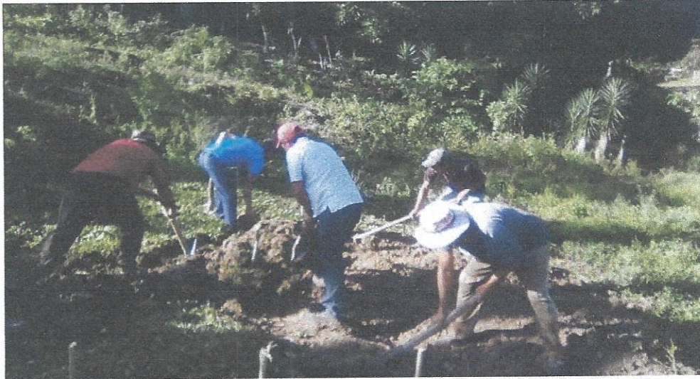
Construcción de tanque de agua, caserío los Altos Sector Perico
