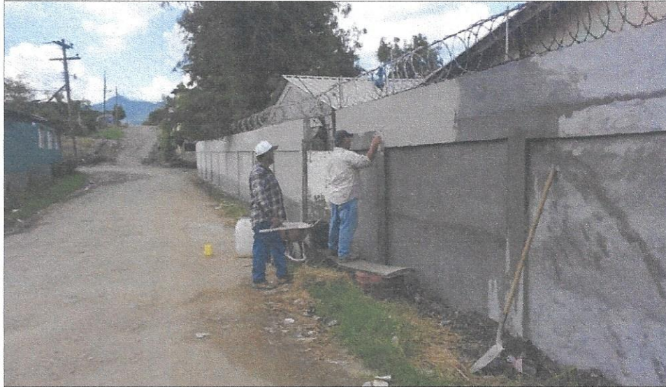
Repello y pulido de cerco perimetral, Escuela Rafael Cantarero Colonia Guadalupe López, Sector Este C
