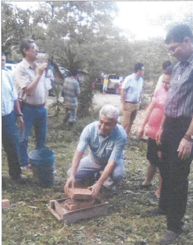
Puesta de la Primera Piedra de construcción de Tanque de agua en Los Años Sector Perico, HidroVolcán, Municipalidad y Participación Ciudadana
