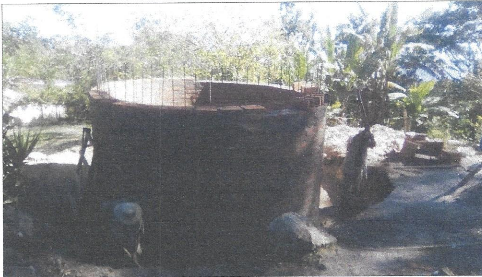
Avances construcción de tanque de agua, caserío los Altos Sector Perico
