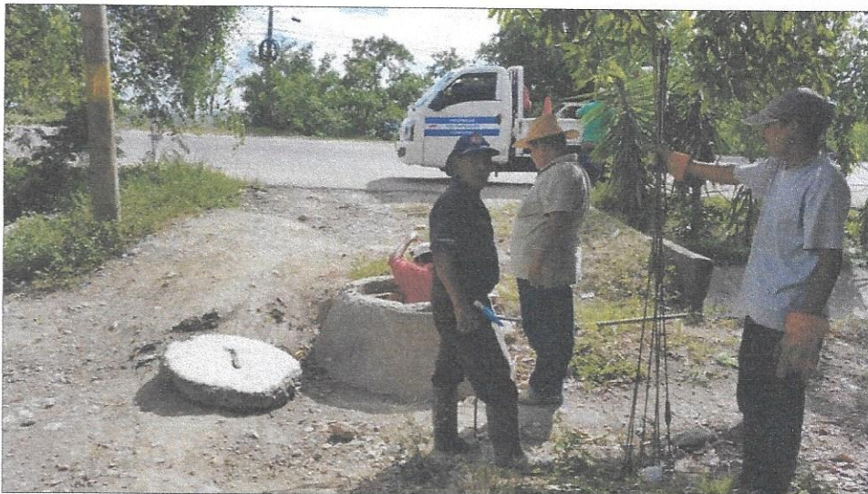
Mantenimiento de holls, Sector Este C
