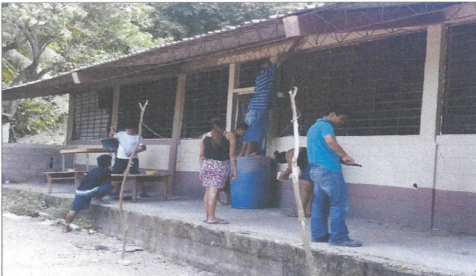
Realizado trabajos de pintura en Centros Educativos, Sector Sinaí
