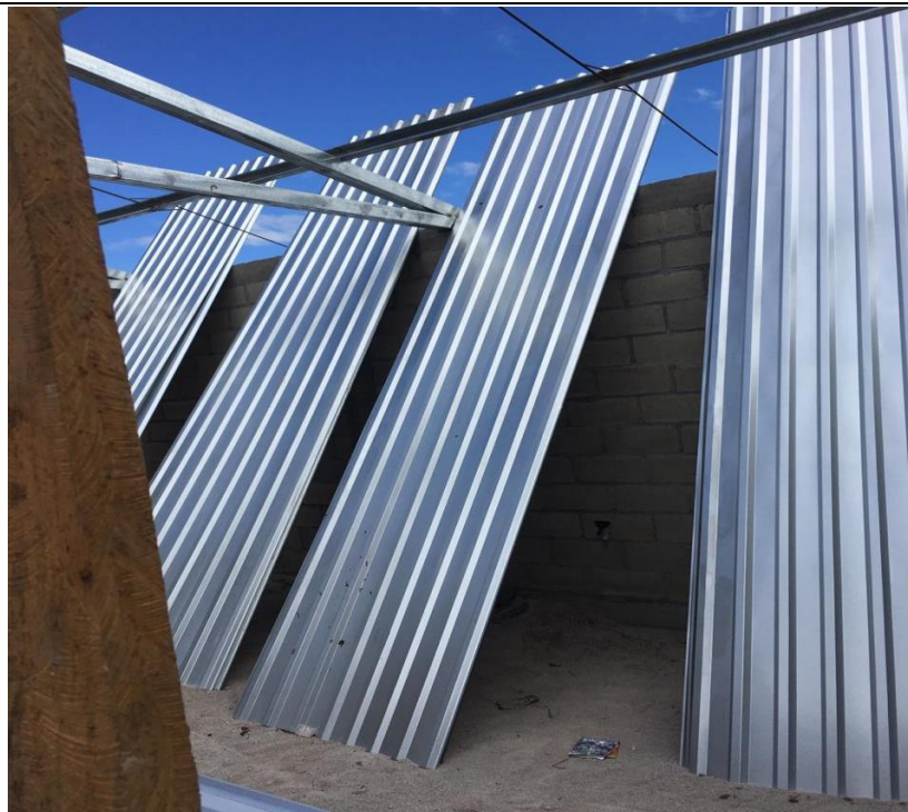
LAMINA DE ALUZINC LISTA PARA SER COLOCADA.
