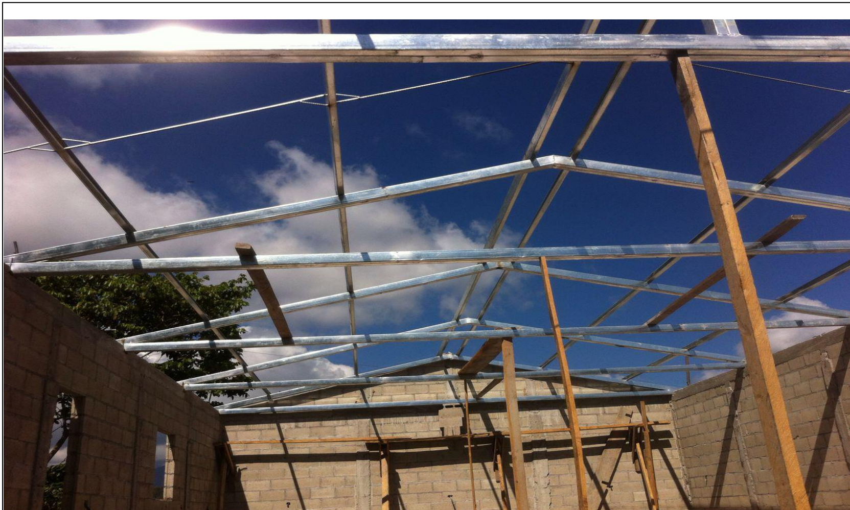
COLOCACION DE TIJERAS.
