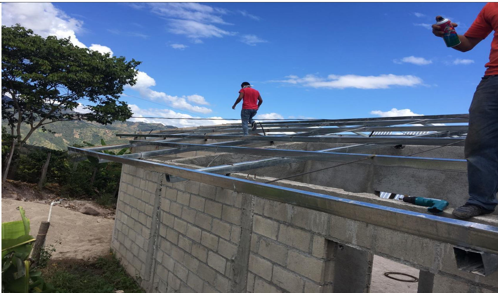
COLOCACION DE ARMADURA DE TECHO(TIJERAS Y LARGUEROS).
