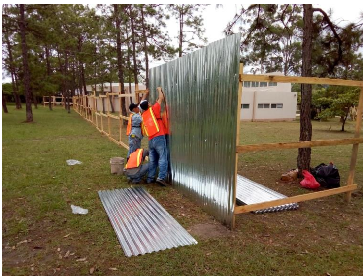
Imagen 2. Instalación de lámina de zinc cal 26.
