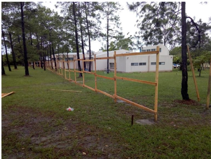
Imagen 1. Anclajes de palos y reglas.
