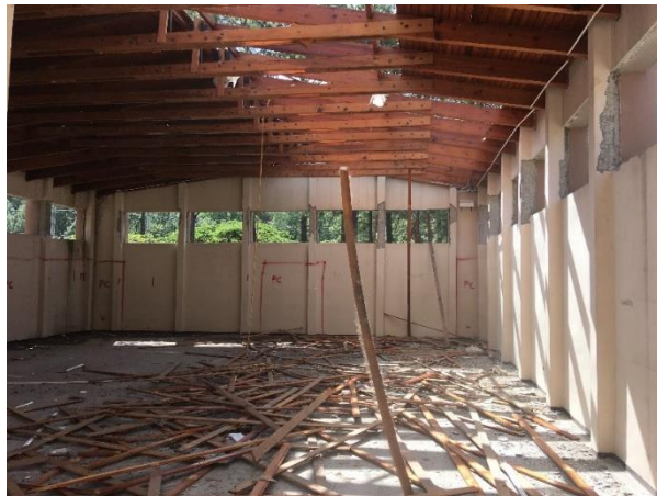
8. Desmontaje de Techo y Cielo Falso
