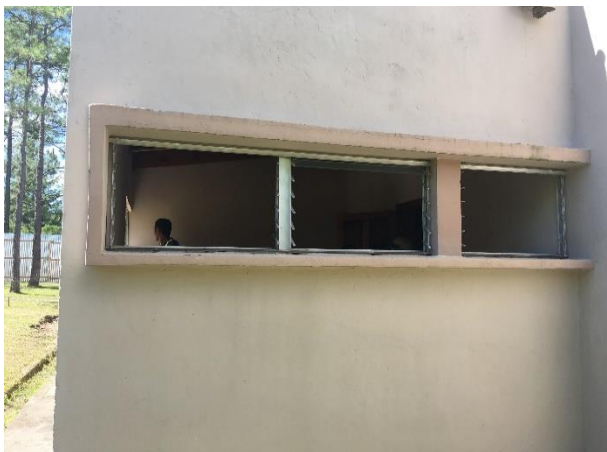
Imagen 7. Desmontaje de Ventanas
