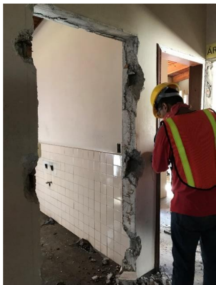
Imagen 5. Desmontaje de Puertas
