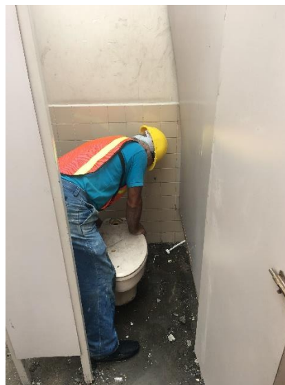
Imagen 6. Desmontaje de batería de baños
