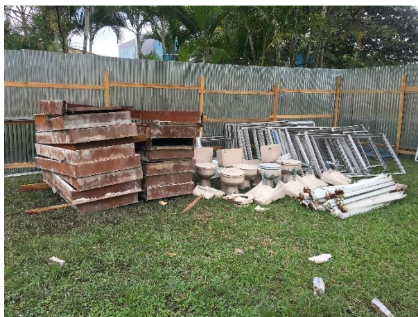
Imagen 9. Material reutilizable proveniente del desmontaje
