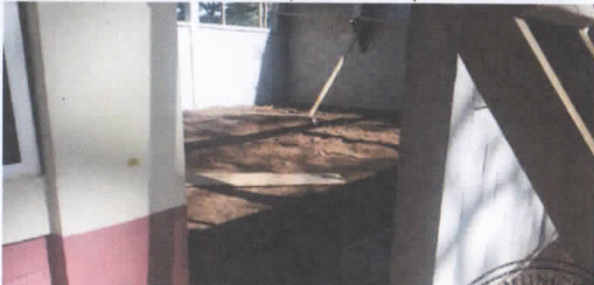
relleno de material para construccion de piso
