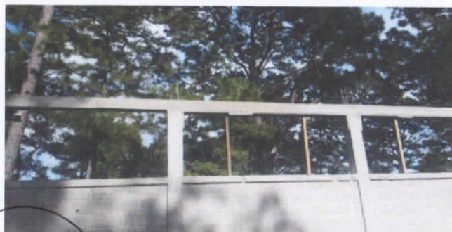
fundicion de soleras a nivel de techo
