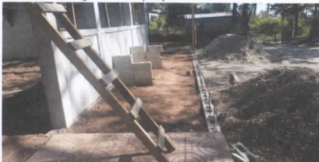
relleno de material selecto para aceras para alrededor del aula
