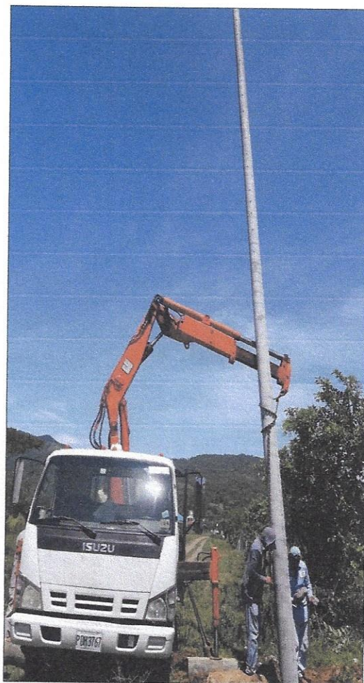
Proyecto de Electrificación, colonia Walter Perdomo, Sector Oeste C
