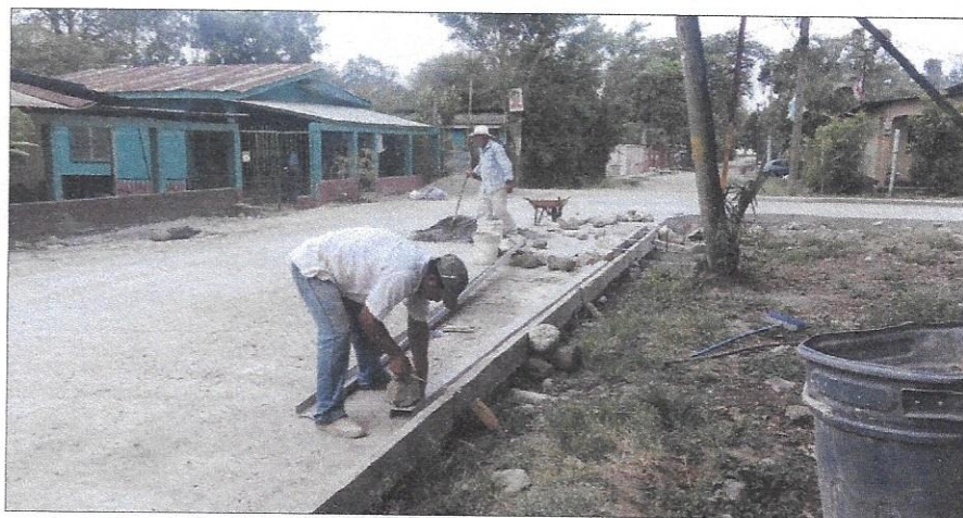
Proyecto de pavimentación, Barrio José Cecilio del Vale
