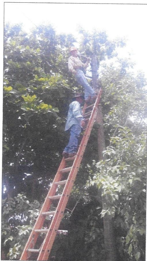
Reparación de alumbrado público en colonia Siboney, Sector Pinto
