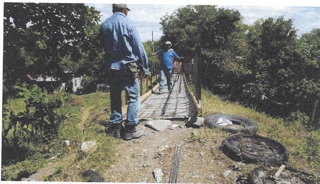
Finalización de reparación de puente Sector Sur Este
