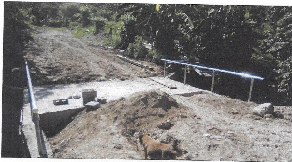
Construcción de puente entre la colonia Felipe Borjas y Cutuquito
