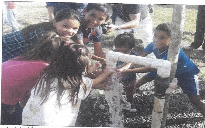
Instalación de la red de agua potable, colonia Walter Perdomo Sector Oeste C
