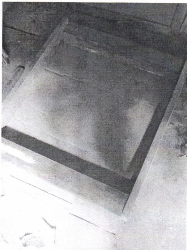
Imagen, molde de la tapadera a reparar.
