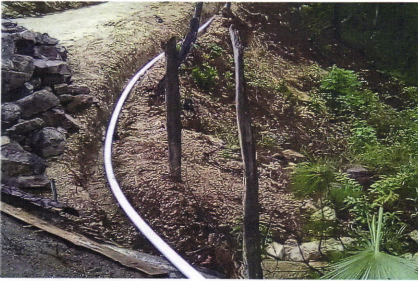
Imagen, Apertura e instalación de tubería, línea de distribución.
