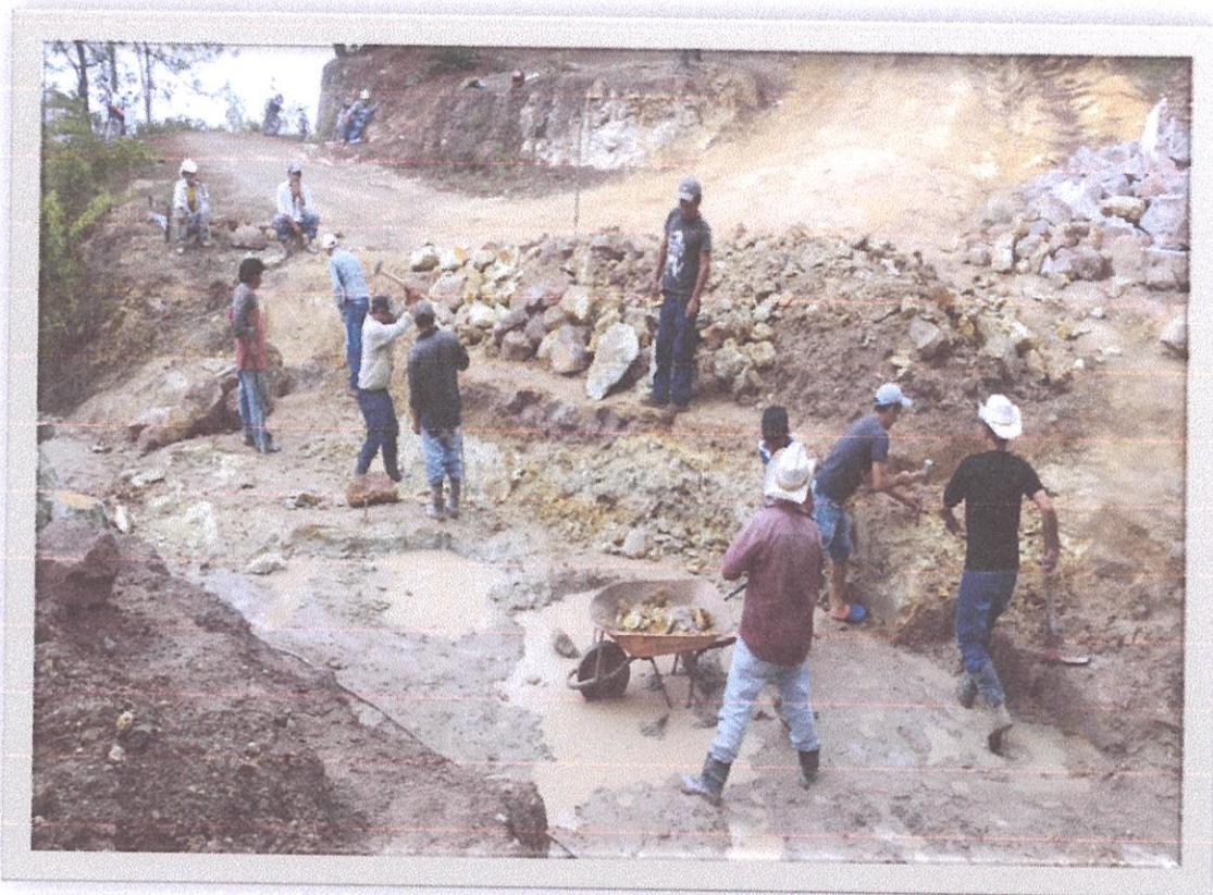
**Proceso de Excavación de terreno donde se construirán los estribos.**
