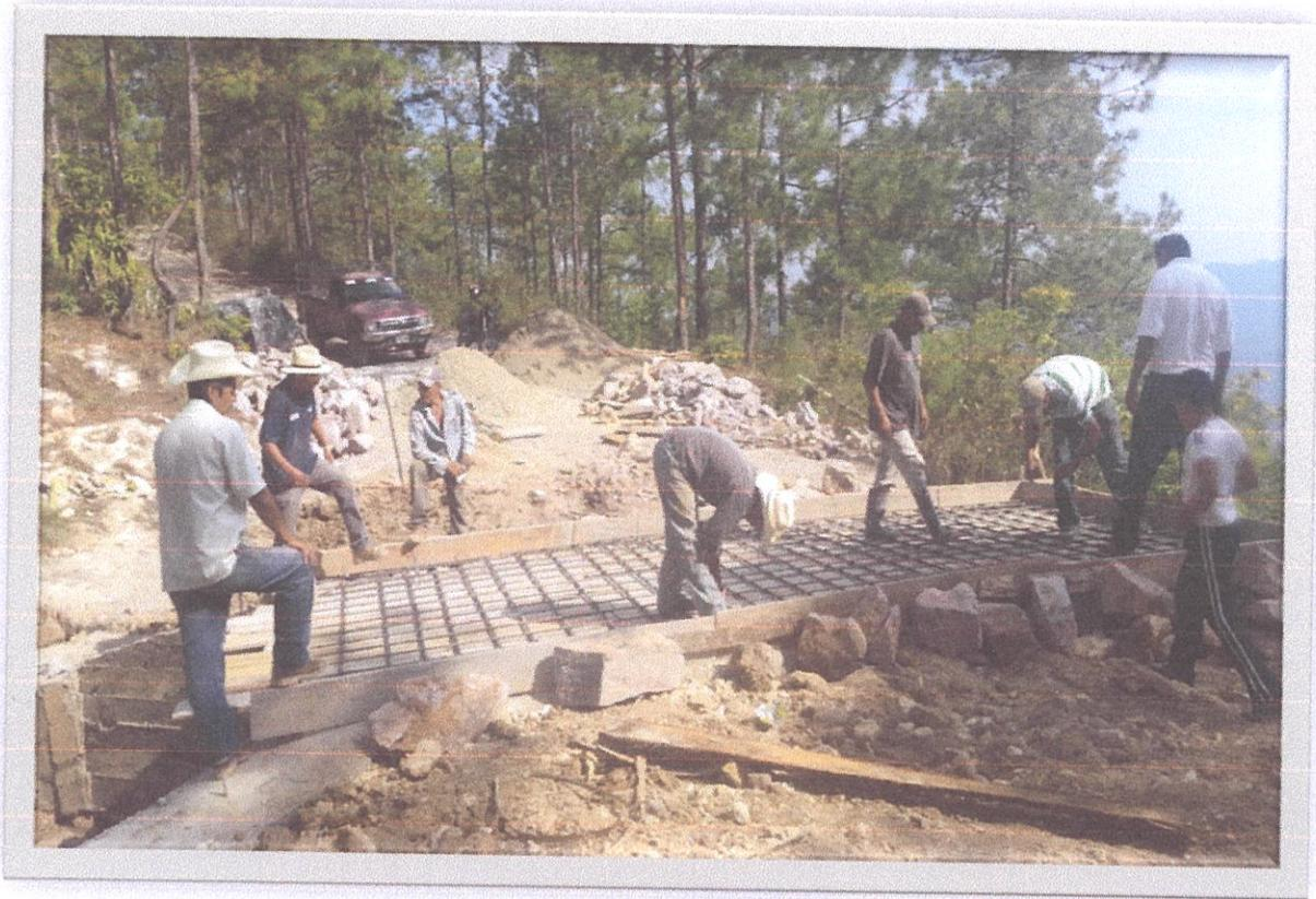
Proceso de Armado de hierro longitudinal y transversal.
