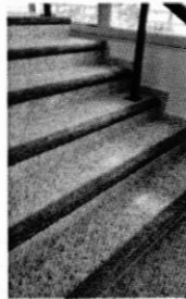
Acabado en Gradas
