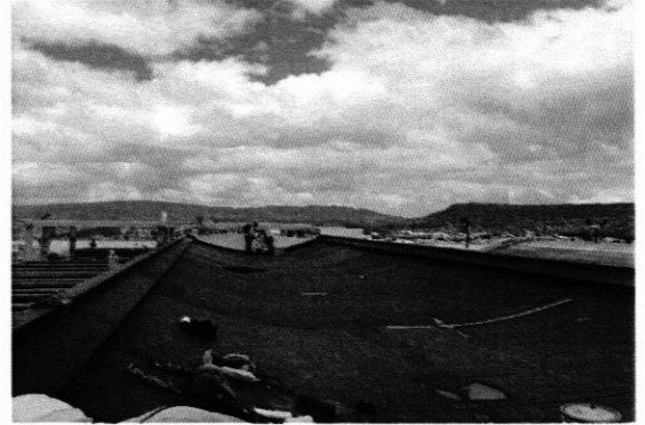
Impermeabilización de techo cóncavo en Azotea.
