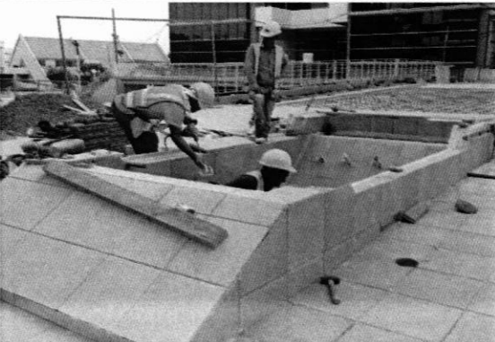
Instalación de enchape de fuente decorativa.
