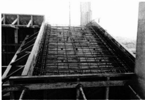
Avance Edificio de Aulas No. 1
