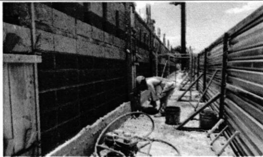
En la imagen se muestra avance del muro en colindancia Oeste
