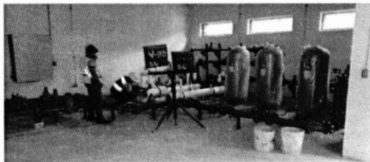
Suministro e instalación de equipo de bombeo
