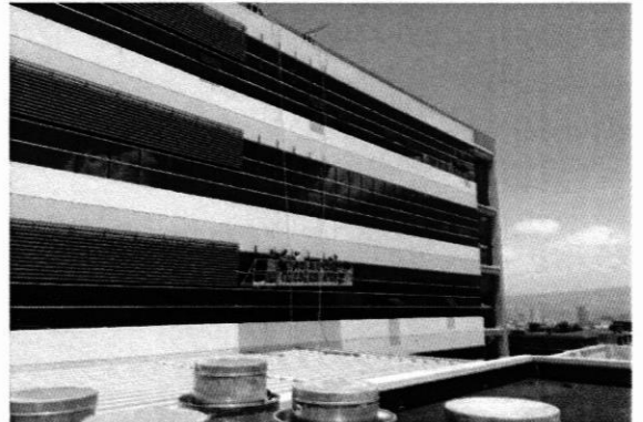
Instalación de louvers en fachada norte.
