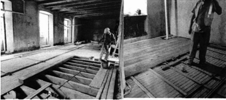
Se trabaja en las instalaciones de la estructura de madera de la losa de entrepisos
