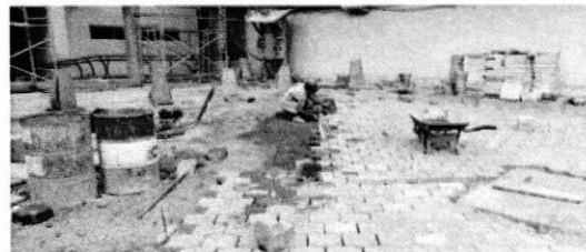
Limpeza de adoquin existente y conformación de superficie de estacionamiento
