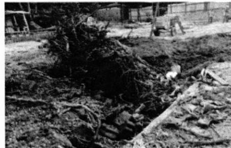
Se realizo realizo remocion de raices de arboles teca en el area del portal peatonal este.
