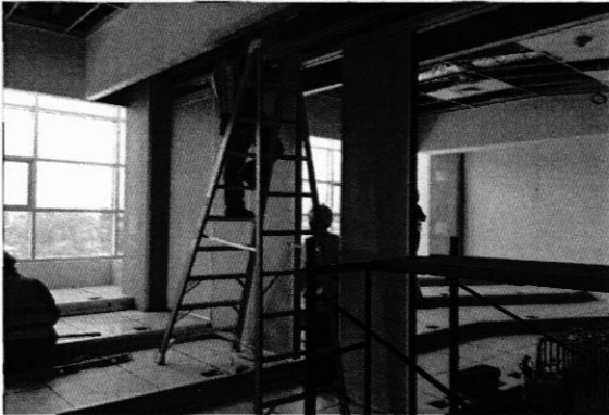
Instalación de panel móvil en aula magistral.
