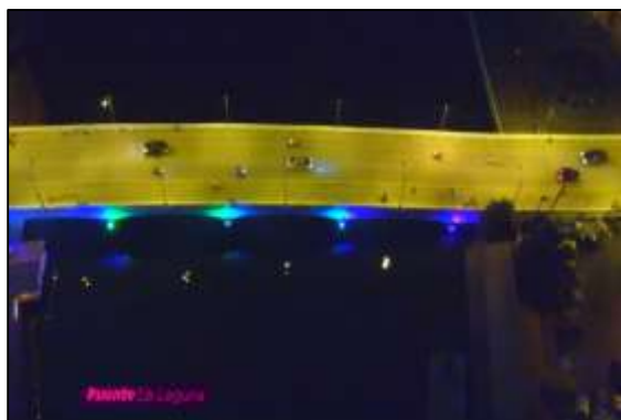
Spot Colorido Puente de La Laguna
