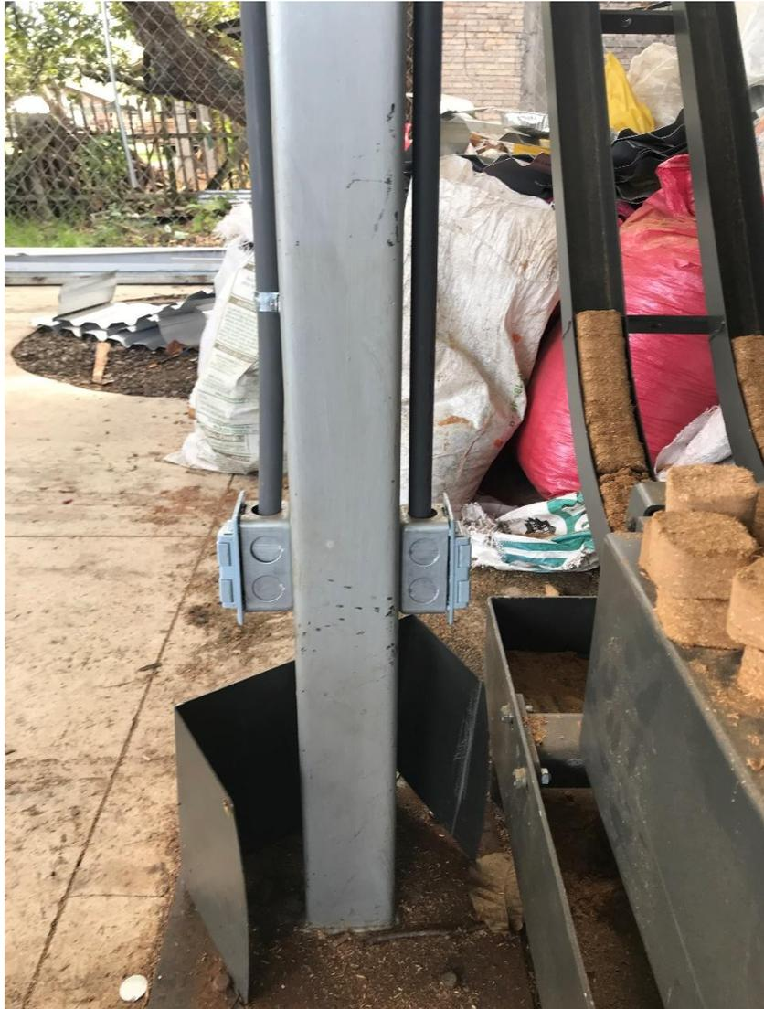
*Imagen 11. Instalación de Tomacorriente 110v y tomacorriente 220v*
