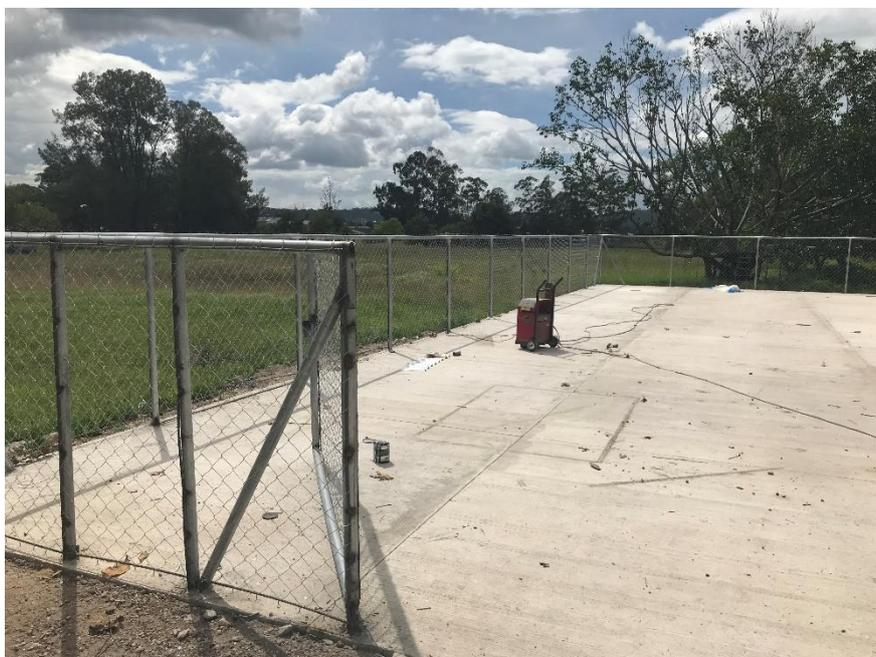
*Imagen 7. Instalación de la Malla ciclón en perímetro*
