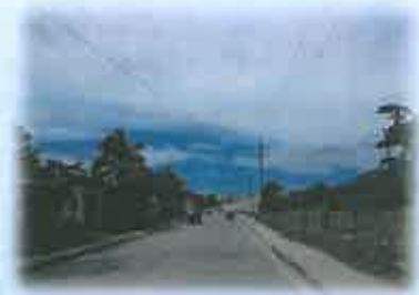
Vista hacia adelante del tramo, todos sus elementos lucen en buen estado
