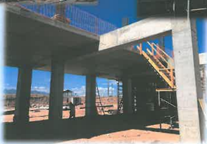
Encofrado y fundición de losa de Nivel de Llegadas en Pier 01 y Pier 03
