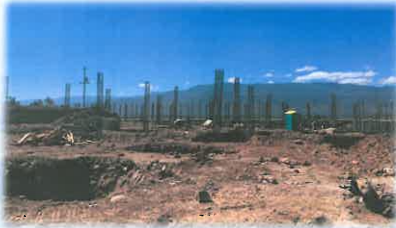
Fundición de zapatas y armado de columnas de Nivel de Llegadas en Edificio Terminal.
