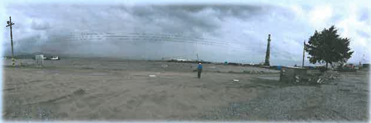
(4) Vista panorámica del futuro muelle No. 6.
