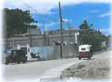
Vista del inicio del tramo
