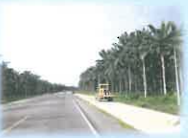
Equipo de construcción en terracerías del km 47
