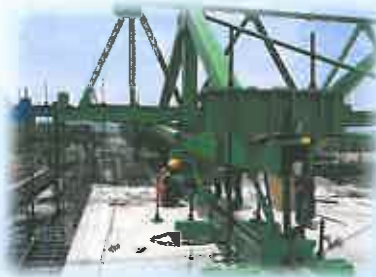
Vista de los carros de avance, en la parte superior del puente
