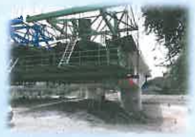
Vista general de la superestructura del puente en la pila No 2
