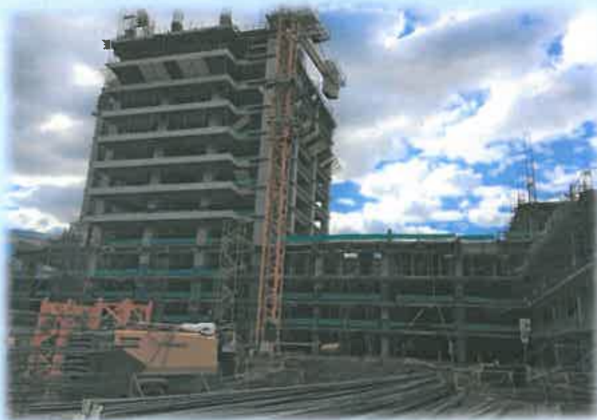
Vista parcial de actividades en Torre 02.
