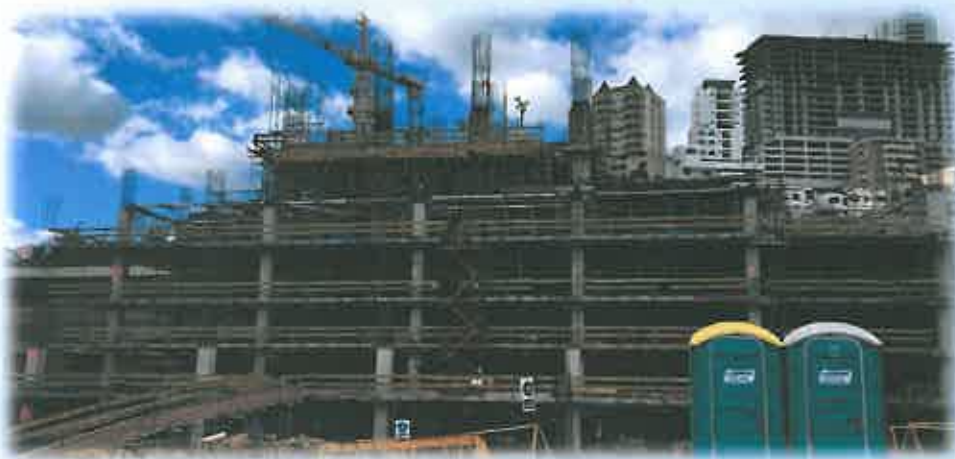
Vista parcial de actividades en Torre 01.
