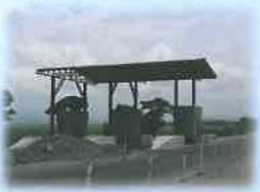
Vista cercana de la misma estación
