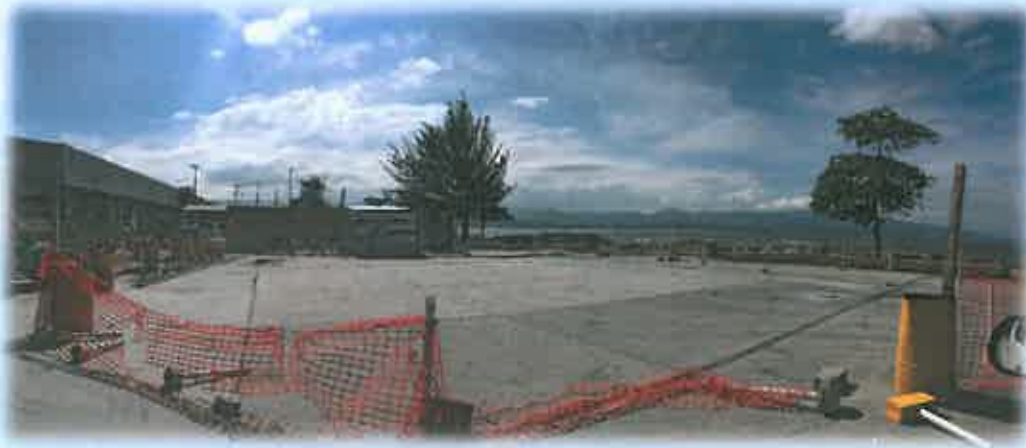
(3) Vista panorámica del área de revisiones C7.
