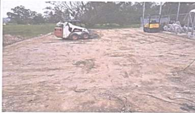
Compactado de selecto
