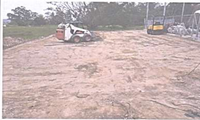
Compactado de selecto
