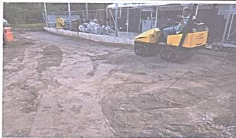
Compactado de selecto
