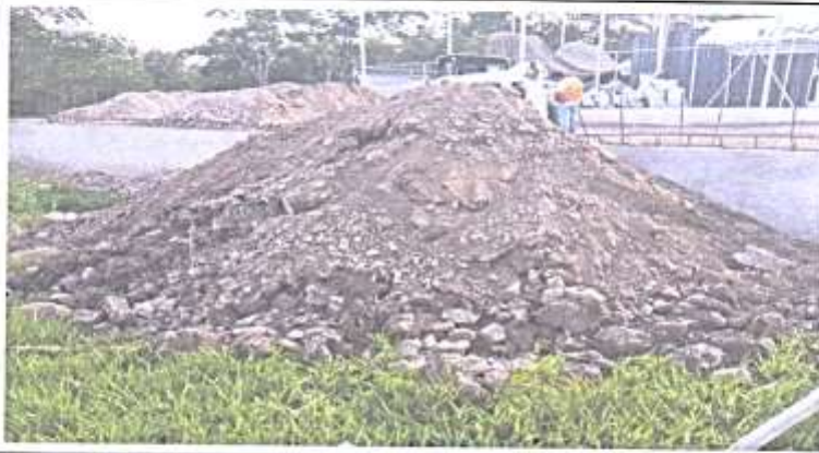
Acarreo y botado de material
