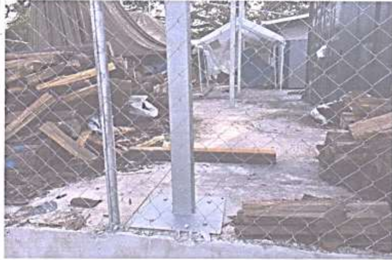
Estructura para Techo
