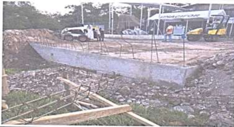
Área de Expansión de losa
