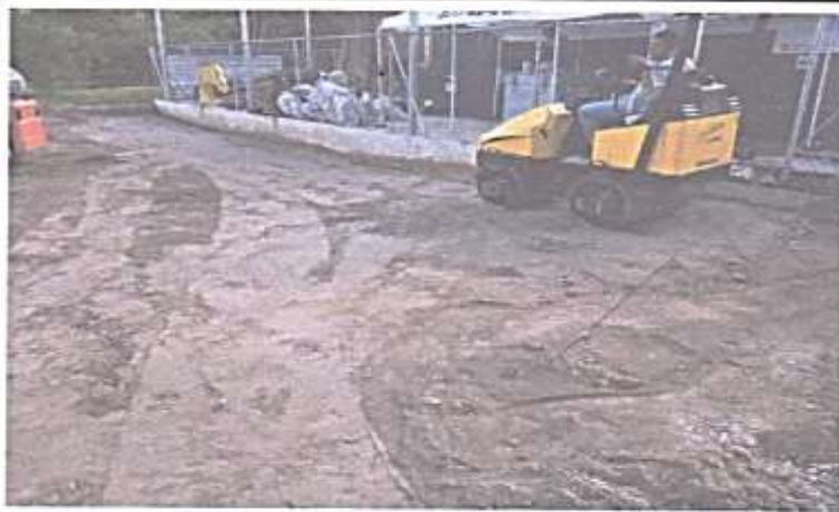
Compactado de selecto
