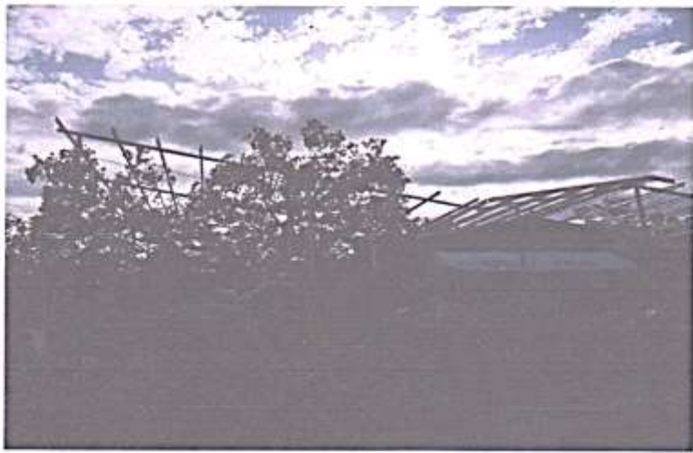
Estructura de techo
