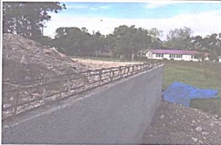
Solera de amarre entre muro y losa
