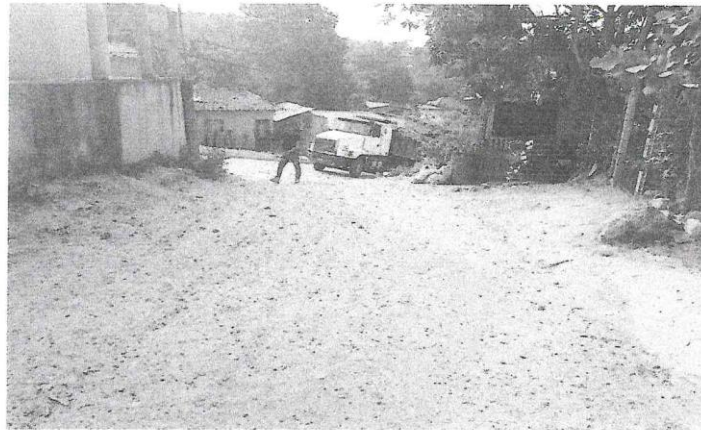
Se visualiza equipo pesado ingresando en punto inicial de pavimentación.
