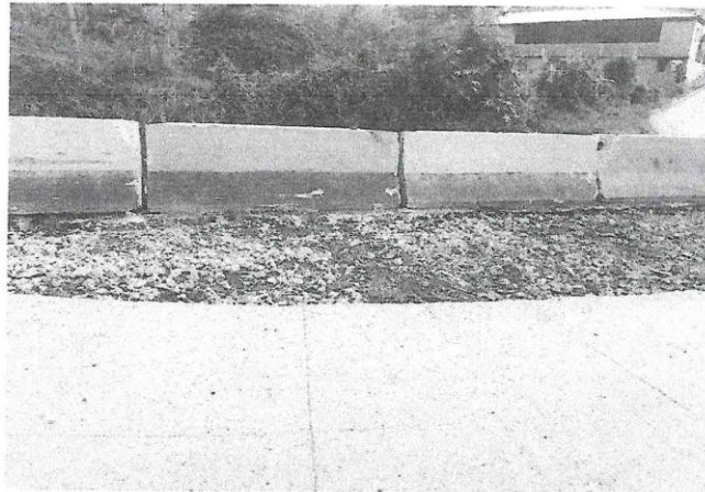
Se visualiza barreras Jersey en el sitio del Proyecto.
