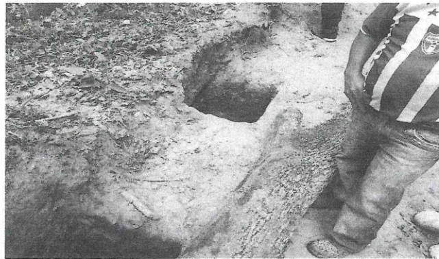
Excavaciones para anclar postes para tensar cables para hamaca.
