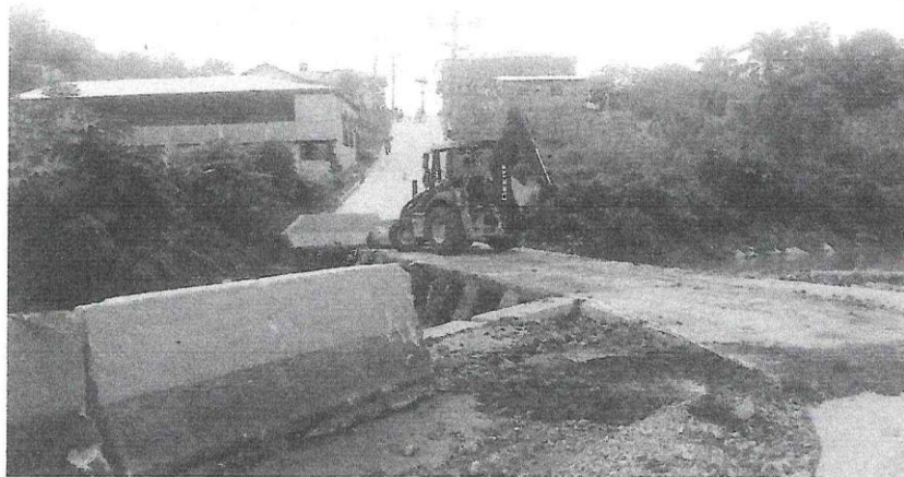
Movilización de barreras Jersey con retroexcavadora propiedad de la municipalidad de Nueva Arcadia.
