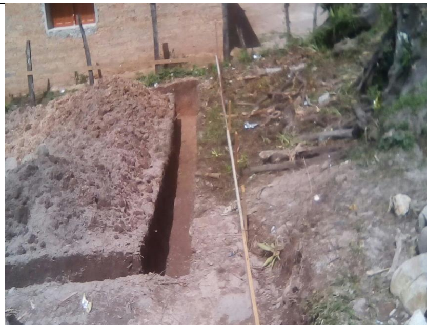
Excavaciones para fundición de zapata corrida de mampostería.
