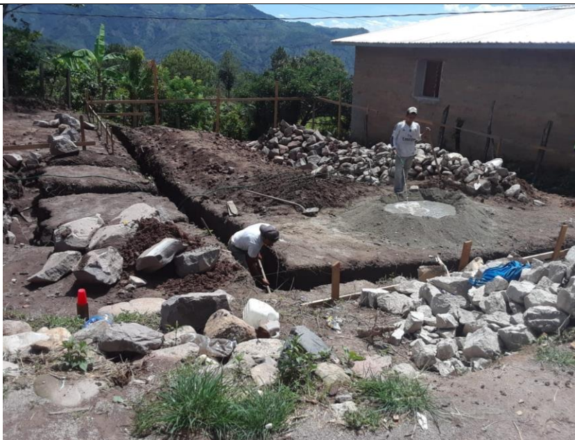
Excavación para fundición de mampostería.
