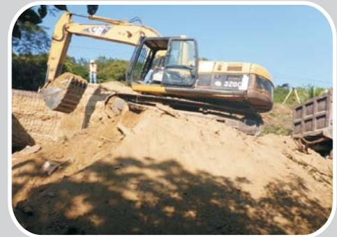
Trabajos de excavación para la instalación de la tubería de concreto reforzado de 48 pulgadas, forman parte de las actividades que se realizan durante el periodo inicial de las obras.
