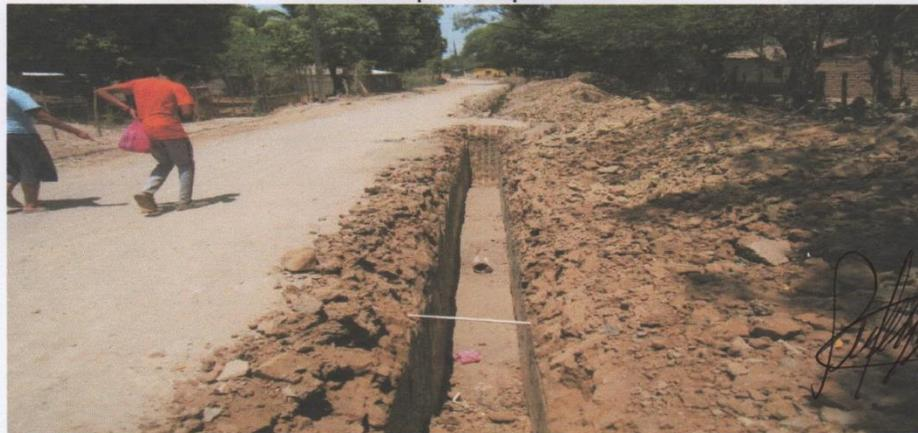
Instalación de tubería pvc de 6", y relleno cama de arena.
