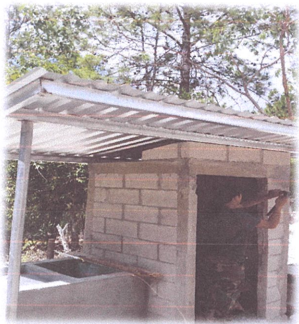
Construcción de techo.
