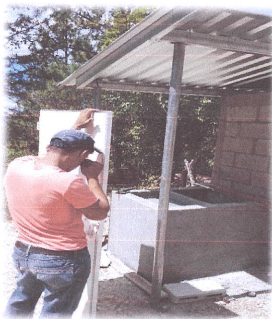
Instalación de puerta
