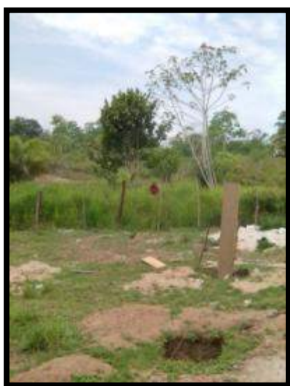
Construcción de Casa del Sr. Mario Hernandez.
