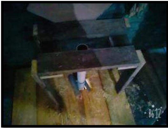
Reparación de casa de la Sra. Margarita de León.
