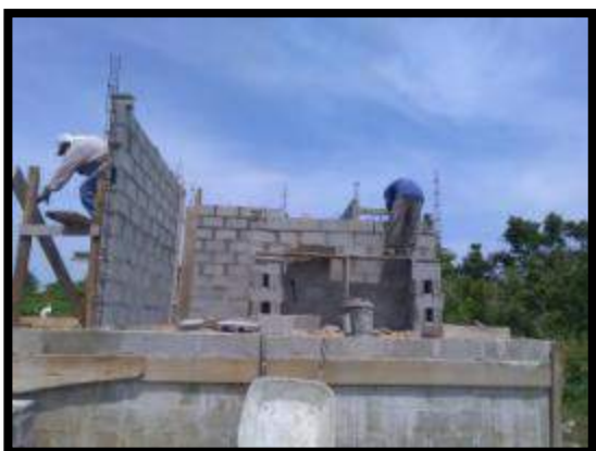
Construcción de casa de la Sra. Fátima Muñoz.
