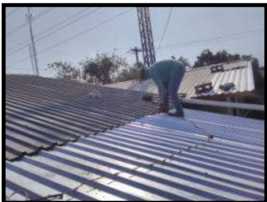
Reparacion de techo en Oficna de Mantenimiento Municipal
