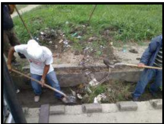
Colocación de Tapaderas en sector El Sofoco de barrio La Laguna
