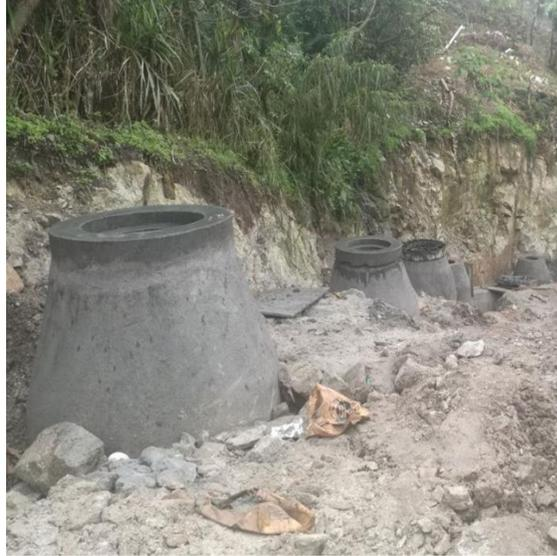
**Construcción de Colector y desvío de la quebrada en tubería reutilizada**
