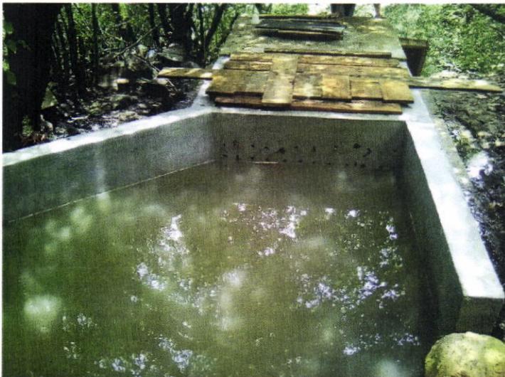
Imagen de la toma de agua (paredes de captación).
